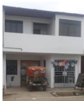
Edificación Analizada N°17
