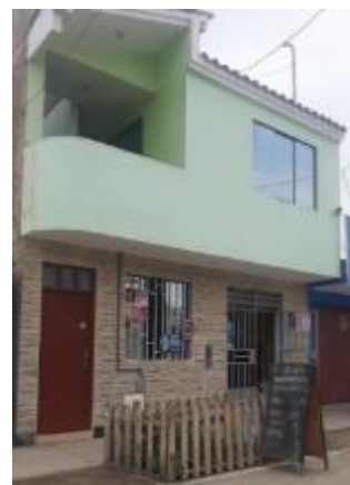
Edificación Analizada N°20
