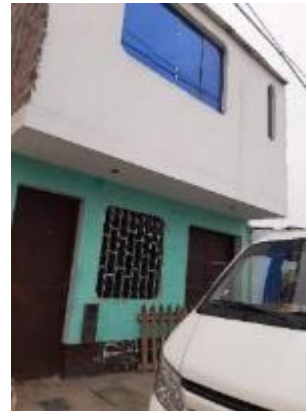
Edificación Analizada N°6
