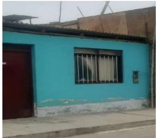
Edificación Analizada N°4
