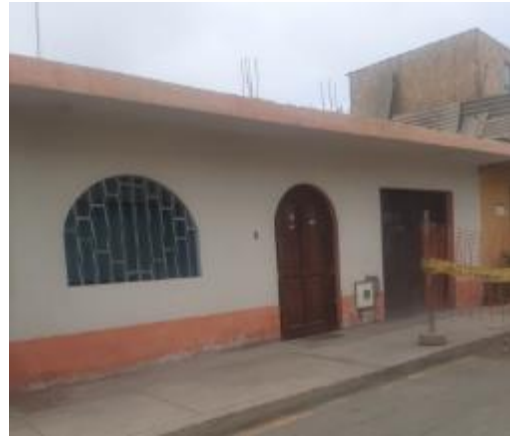
Edificación Analizada N°12
