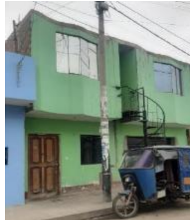
Edificación Analizada N°8
