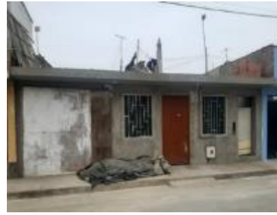
Edificacion N°10, se visualiza que es de un solo piso, presenta muros con ladrillo pandereta, con porton de triplay.
