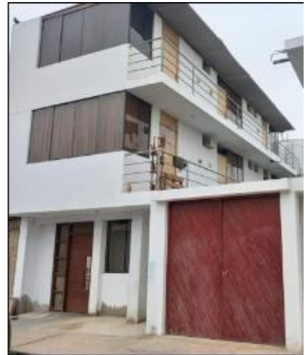
Edificación Analizada N°14
