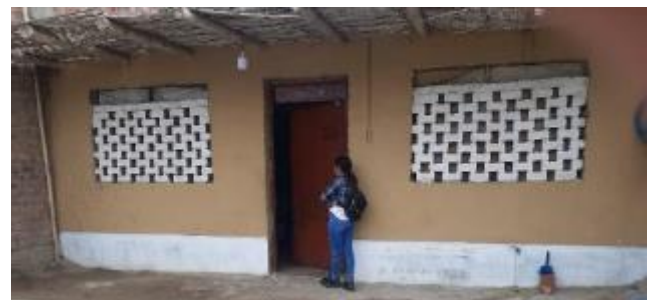
Edificación Analizada N°7
