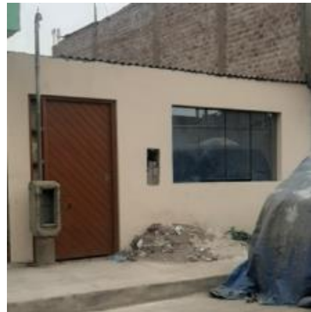
Edificación Analizada N°5
