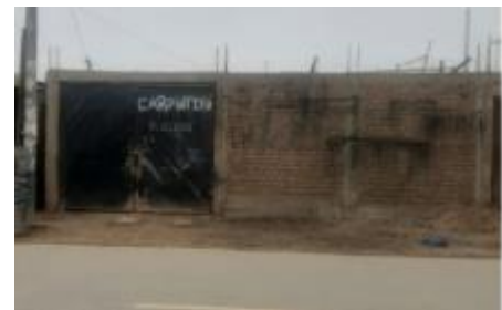
Edificación Analizada N°23
