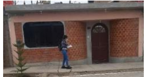
Edificación Analizada N°18
