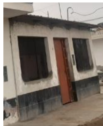
Edificación Analizada N°21
