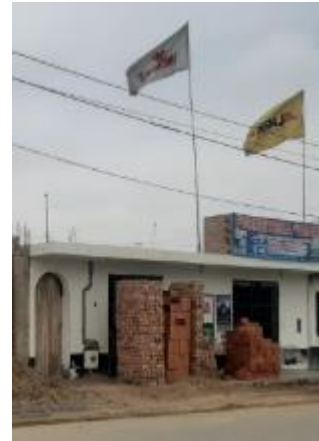
Edificación Analizada N°22
