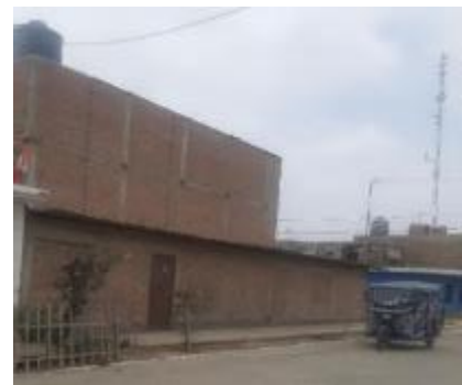
Edificación Analizada N°15
