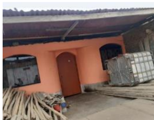
Edificación Analizada N°24
