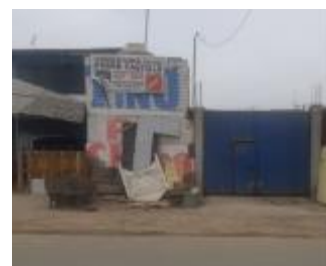
Edificación Analizada N°1
