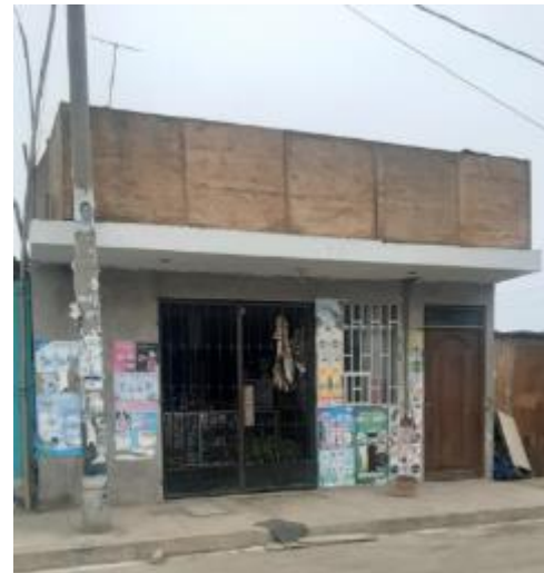
Edificación Analizada N°3
