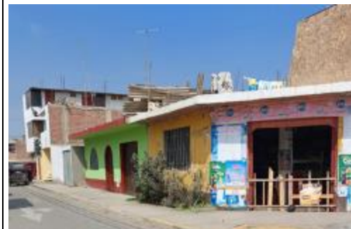
Se observa las edificaciones del pasaje San Jose. En el lote 11, se ubica la unica vivienda de 3 pisos, donde el material
