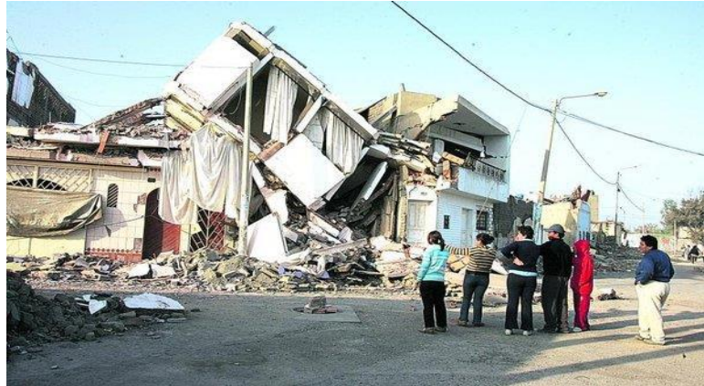
Figura 11 viviendas de adobe y quincha afectadas por el sismo de 1974
