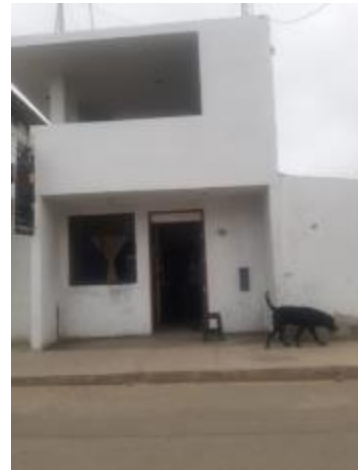
Edificación Analizada N°13
