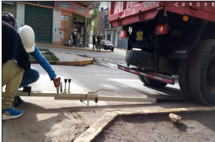
Fotografía 16. Colocación de la viga Benkelman en el punto a evaluar, Prog. 0+750 (vuelta).
