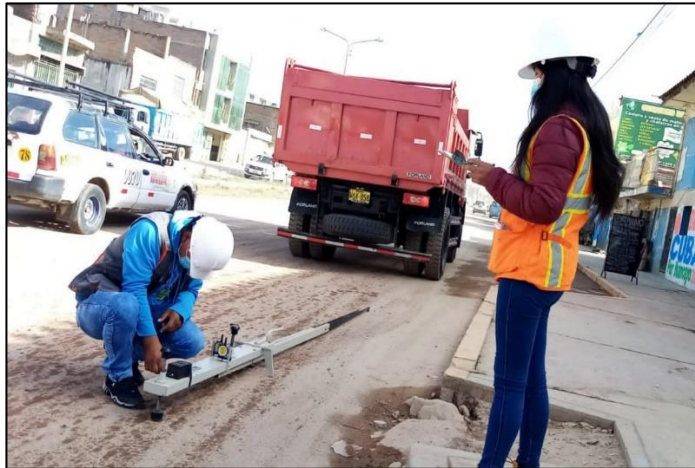
Fotografía 13. Colocación de la viga Benkelman en el punto a evaluar, Prog. 0+050 (vuelta).
