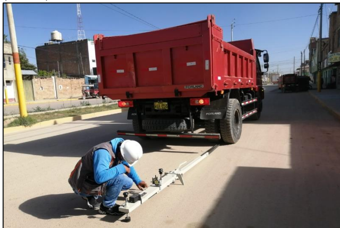
Fotografía 14. Colocación de la viga Benkelman en el punto a evaluar, Prog. 0+350 (vuelta).
