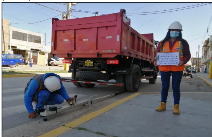
Fotografía 15. Colocación de la viga Benkelman en el punto a evaluar, Prog. 0+625 (vuelta).
