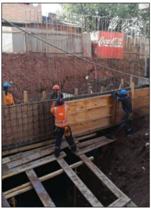
Fotografía 5. Vista de la colocación de acero y encofrado para el vaciado de concreto de las cimentaciones.
