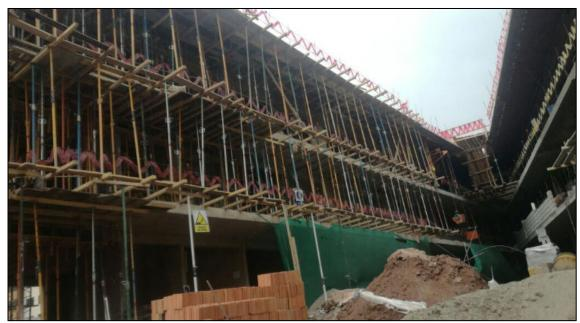
Fotografía 12. Vista del encofrado de la infraestructura educativa, además de la disposición de materiales que se encuentran dentro del área de ejecución.
