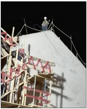
Fotografía 6. Vista del encofrado de la losa aligerada a dos aguas.
