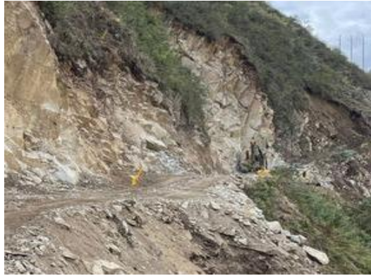
Figura 1. 2 Vista de las vías sin mantenimiento
