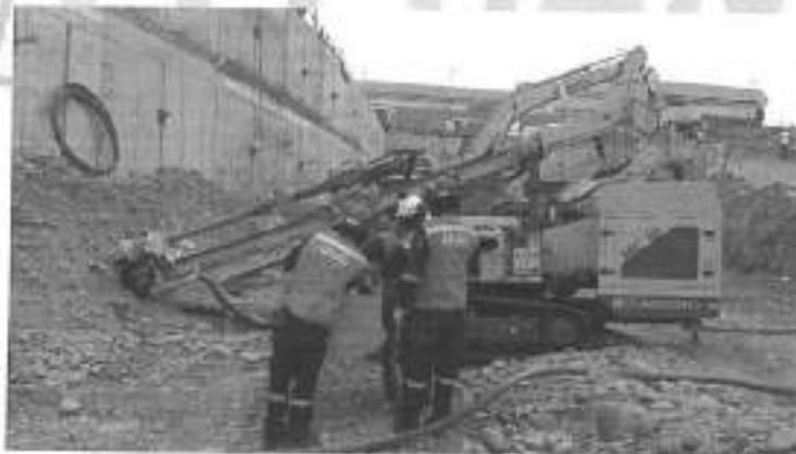
El sistema de estabilización propuesto a lo largo del perímetro correspondiente a la referida edificación y el alcance de esta propuesta, contempla la perforación, suministro, instalación y tensado de **28 (233.80 mL<sub>a</sub>) anclajes post-tensados temporales**.
