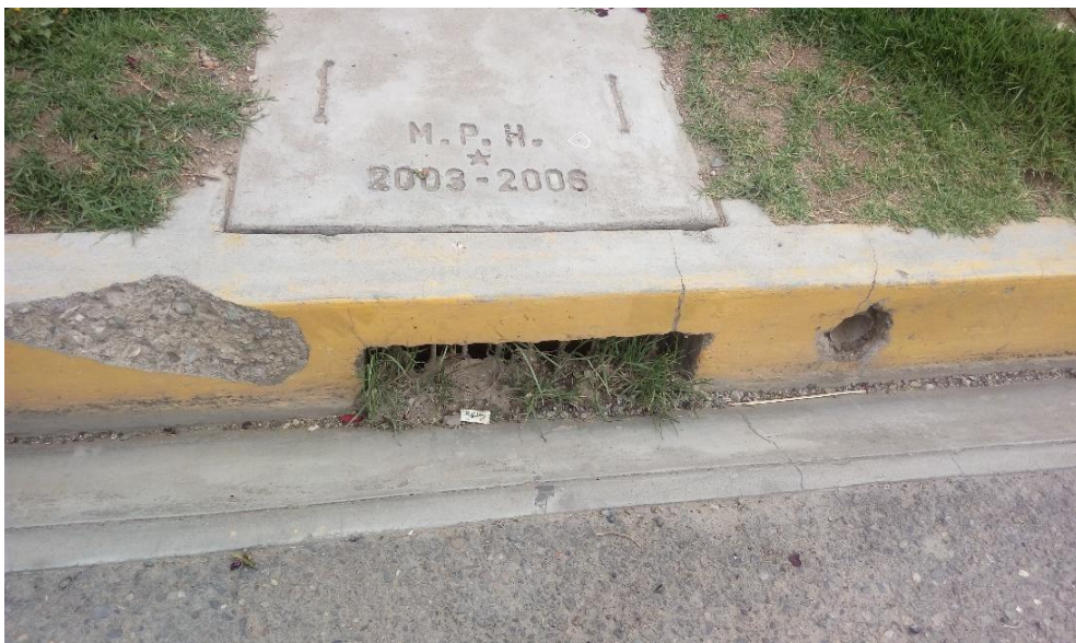
Figura 5. Sumideros tapados por malezas de barro seco
