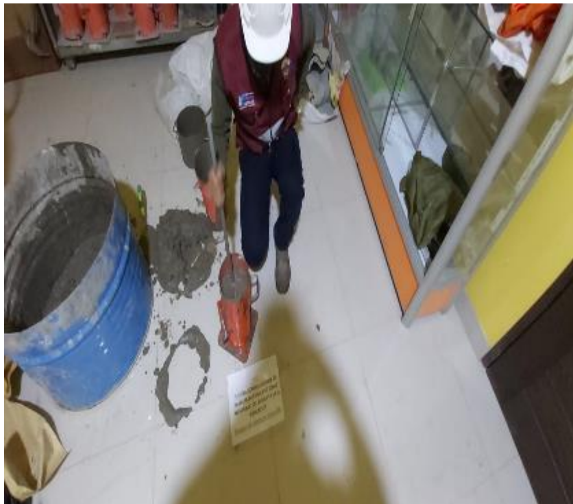
Fotografía 18. Preparación del concreto en cilindros.
