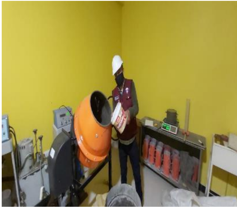
Fotografía 17. Preparación del concreto.
