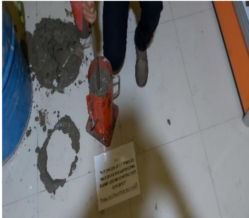
Fotografía 19. Preparación del concreto en cilindros.
