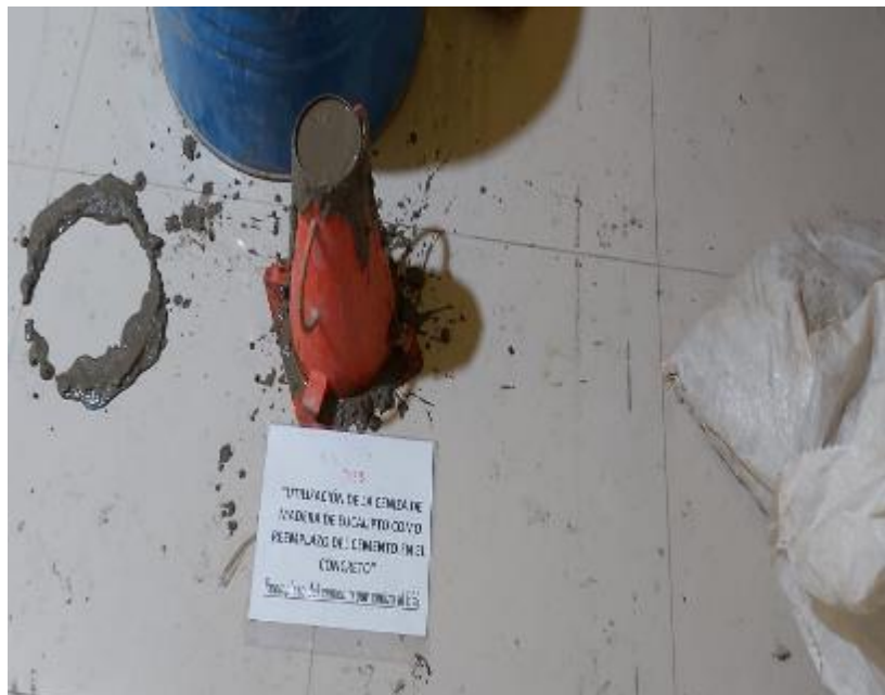
Fotografía 10. Medición del asentamiento del concreto.
