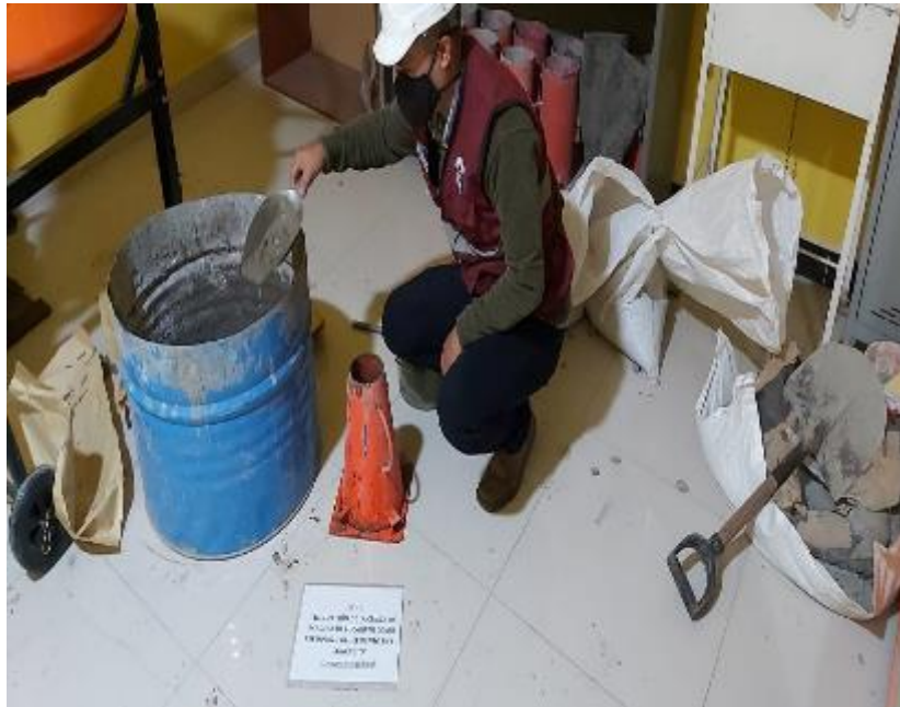
Fotografía 7. Realización de las mezclas para concreto.
