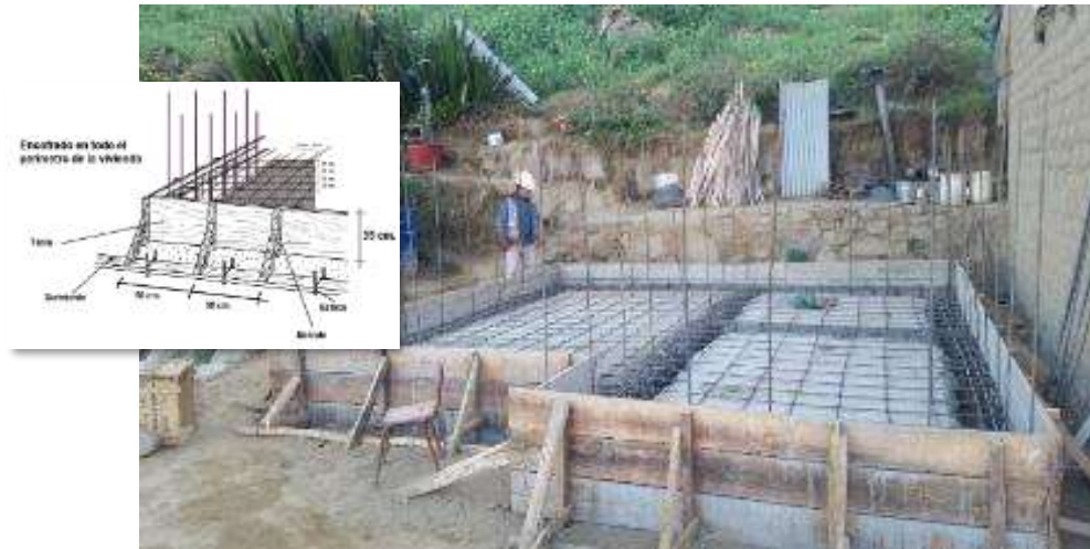
Figura 4.17 Encofrado de losa
