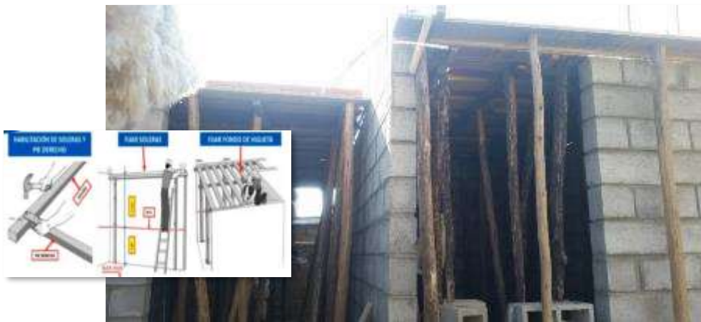
Figura 4.21 Encofrado de loza
