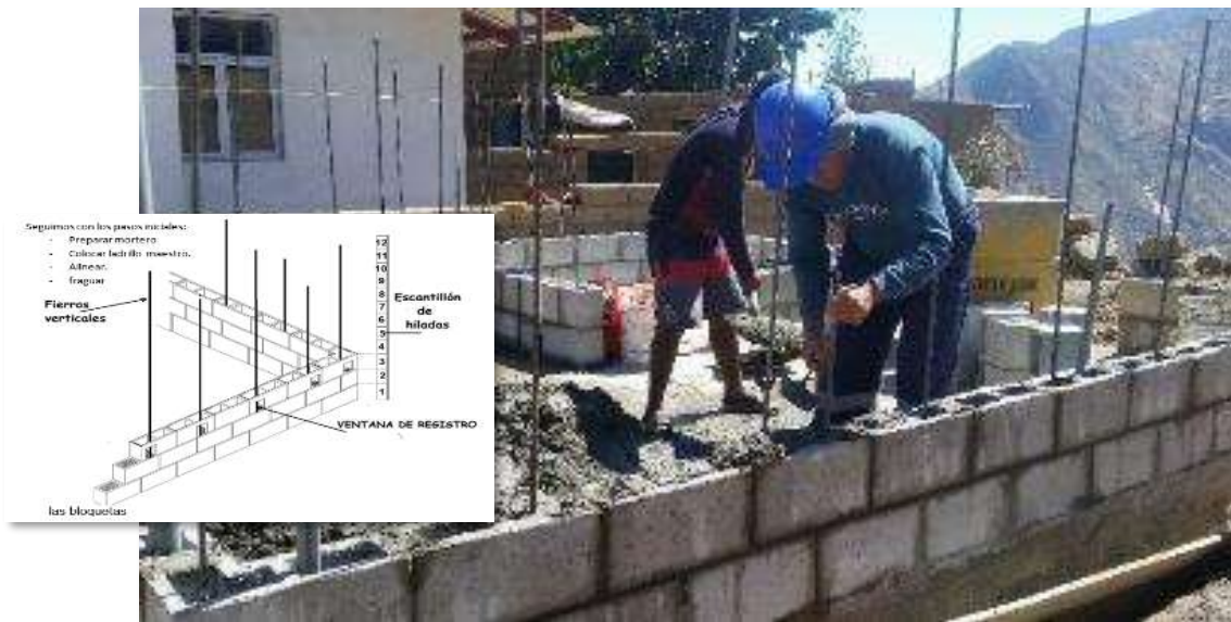
Figura 4.19 Asentado de bloquetas 1 y 2
