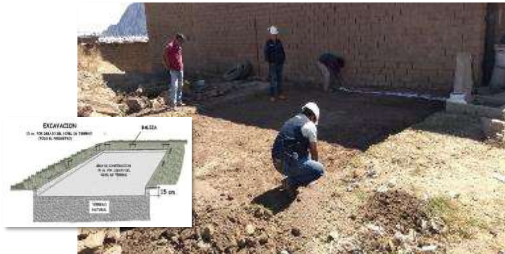
Figura 4.9 Excavación de perímetro
