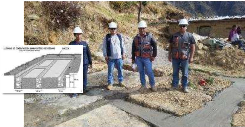
Figura 4 11 concreto en cimientos
