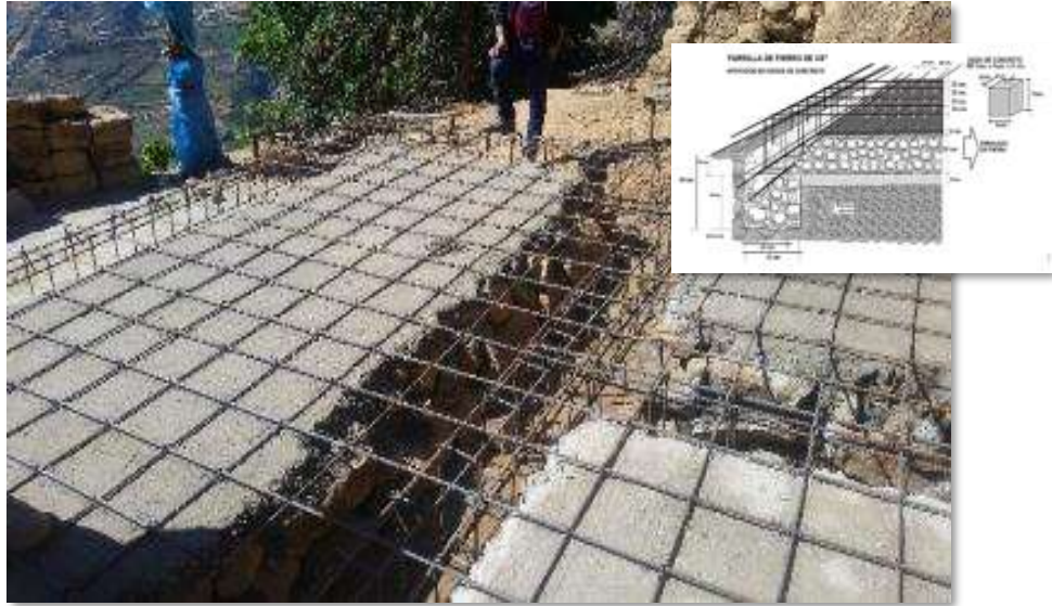
Figura 4 15 Distribución de aceros horizontal.
