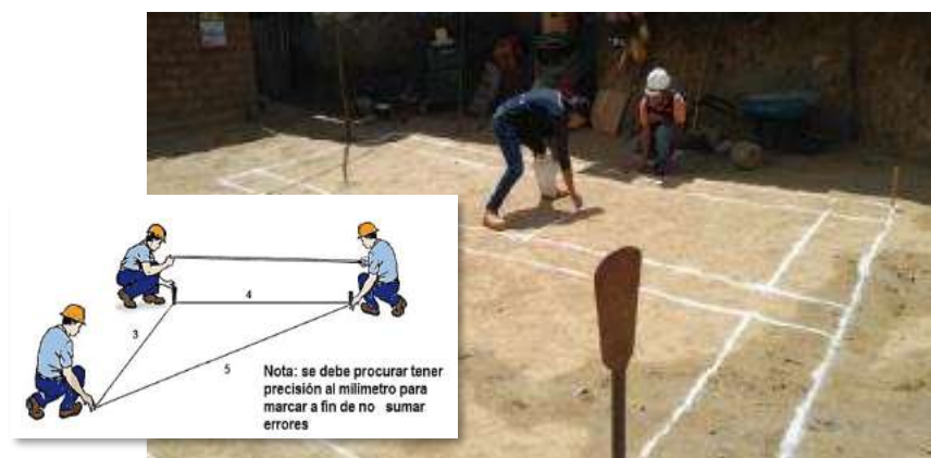
Figura 4.8 Trazo y replanteo
