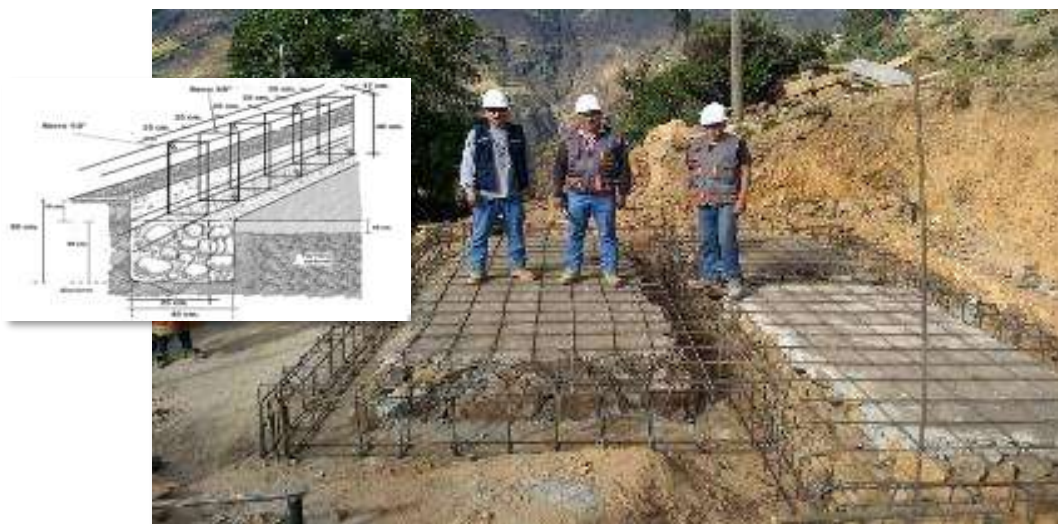
Figura 4.12 Vigas en losa de cimentación
