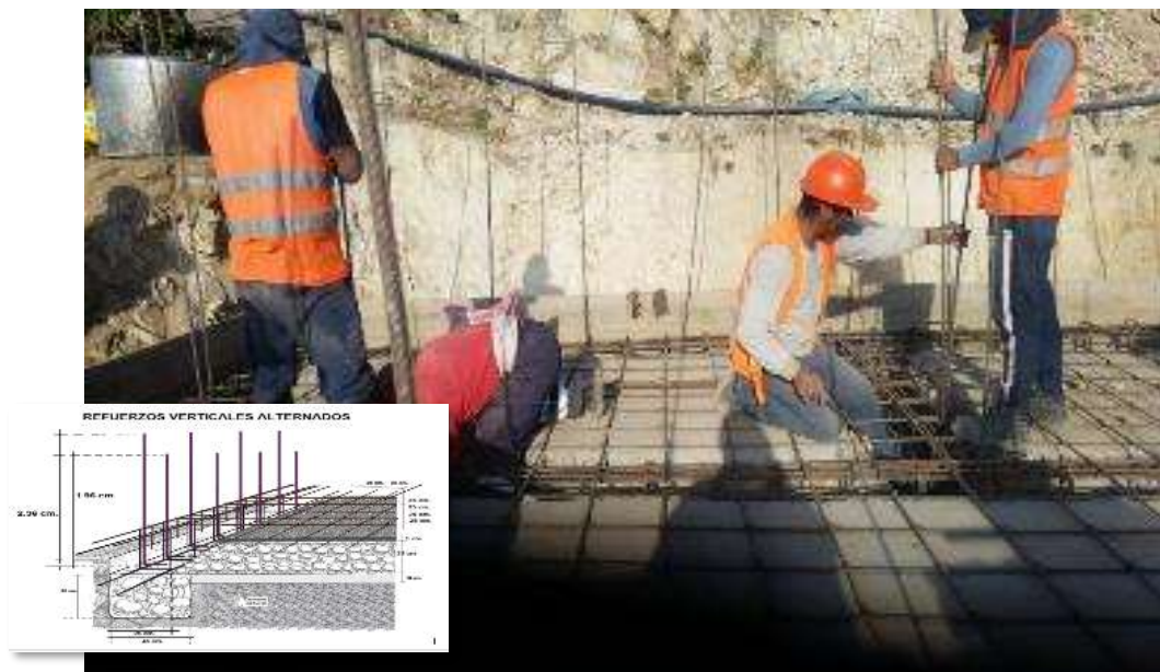
Figura 4.16 Distribución de aceros vertical
