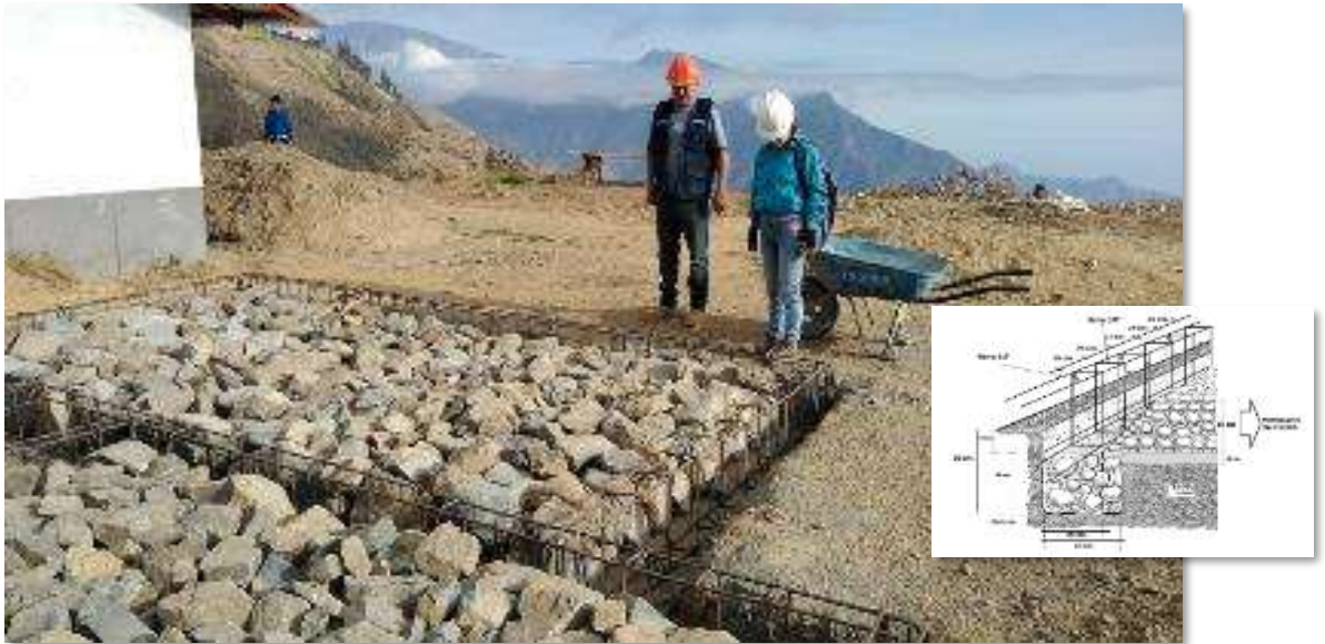
Figura 4.13 Enrocado el sobrecimiento
