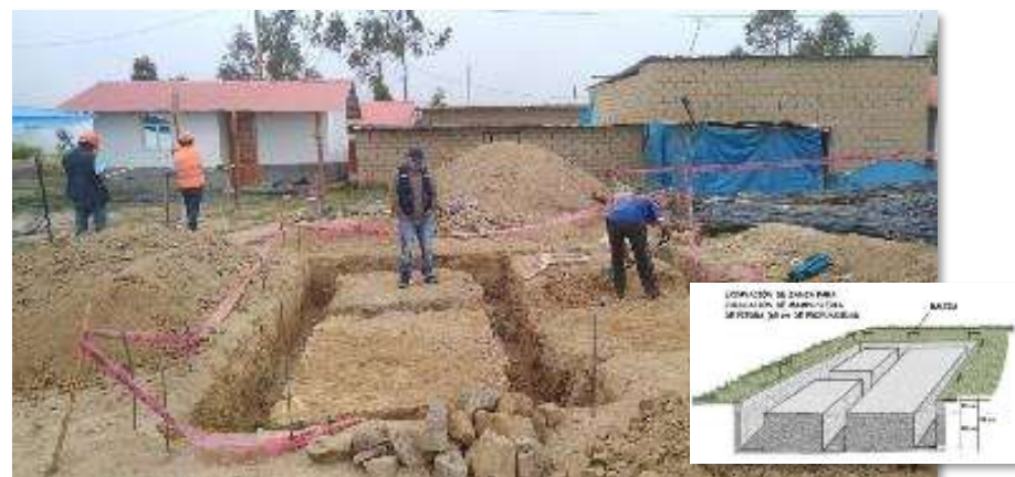
Figura 4.10 Excavación de zanja para cimientos
