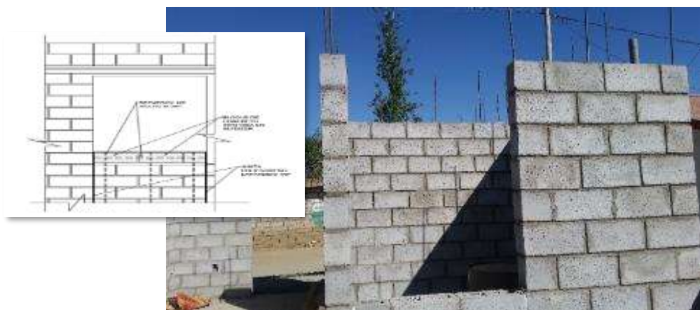
Figura 4.20 Asentado de bloques
