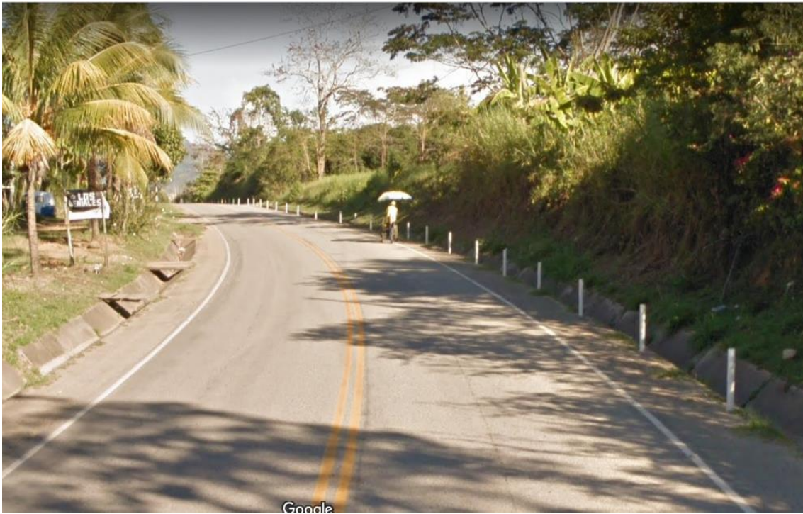
Fotografía N° 4: Vista de las cunetas existentes a ambos lados de la vía.
