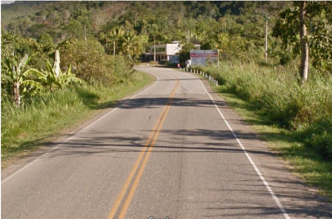
Fotografía N° 3: Vista del diseño geométrico existente de la vía.
