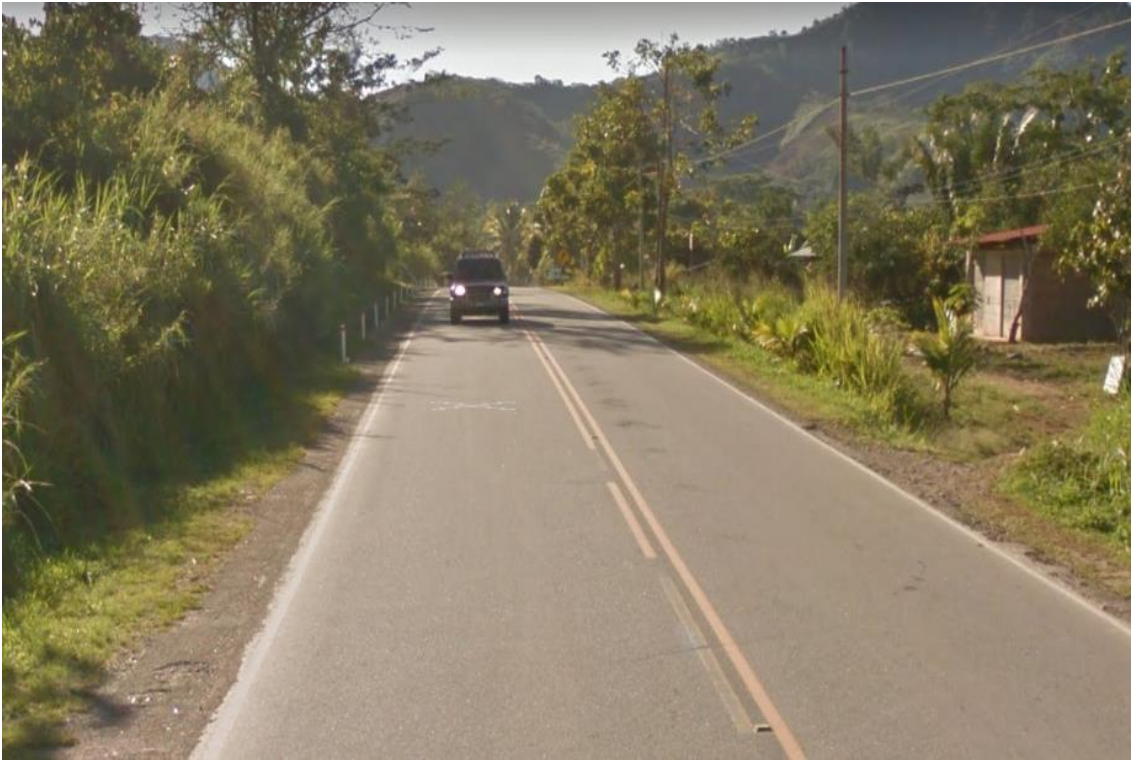
Fotografía N° 1 Inicio del tramo vial carretera Rio Negro – Satipo
