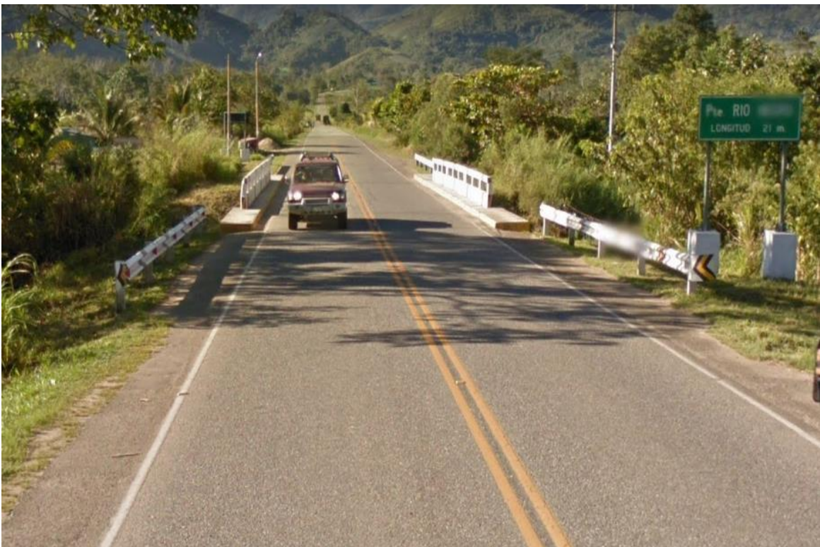
Fotografía N° 2: Fin del tramo vial carretera Rio Negro – Satipo
