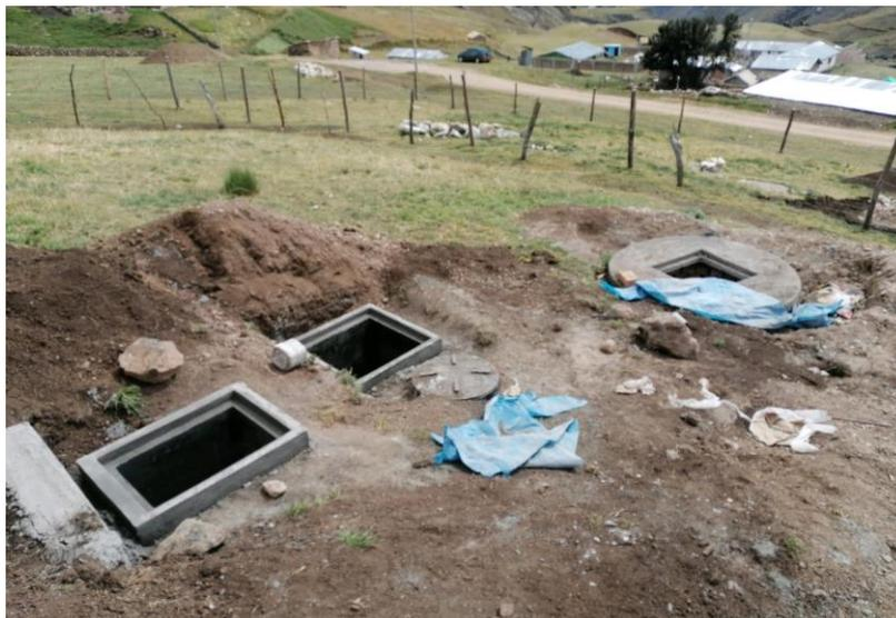
Vista de de caja de registro, caja de lodos, biodigestor, pozo percolador de la unidad basica de saneamiento tipo arrastre hidraulico
