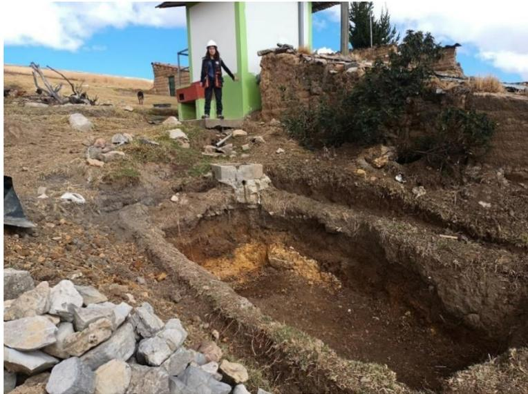
Excavación para el humedal de 1.30 de ancho, altura de 0.60, longitud de 2.60 en la base, para la unidad baica de saneamiento
