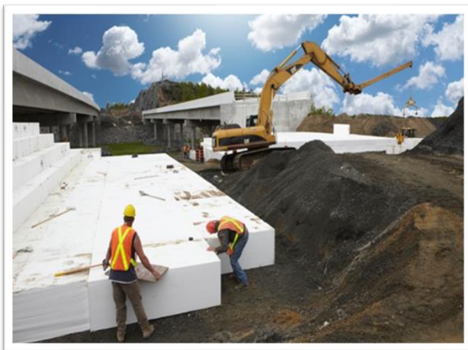
Imagen 8: el poliestireno es usado en forma de material de construcción.
