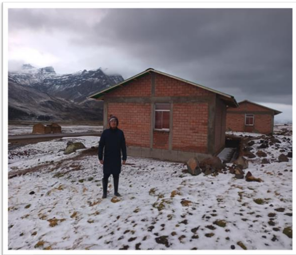
Imagen 1: vivienda con incorporación del poliestireno Centro poblado de Astobamba
