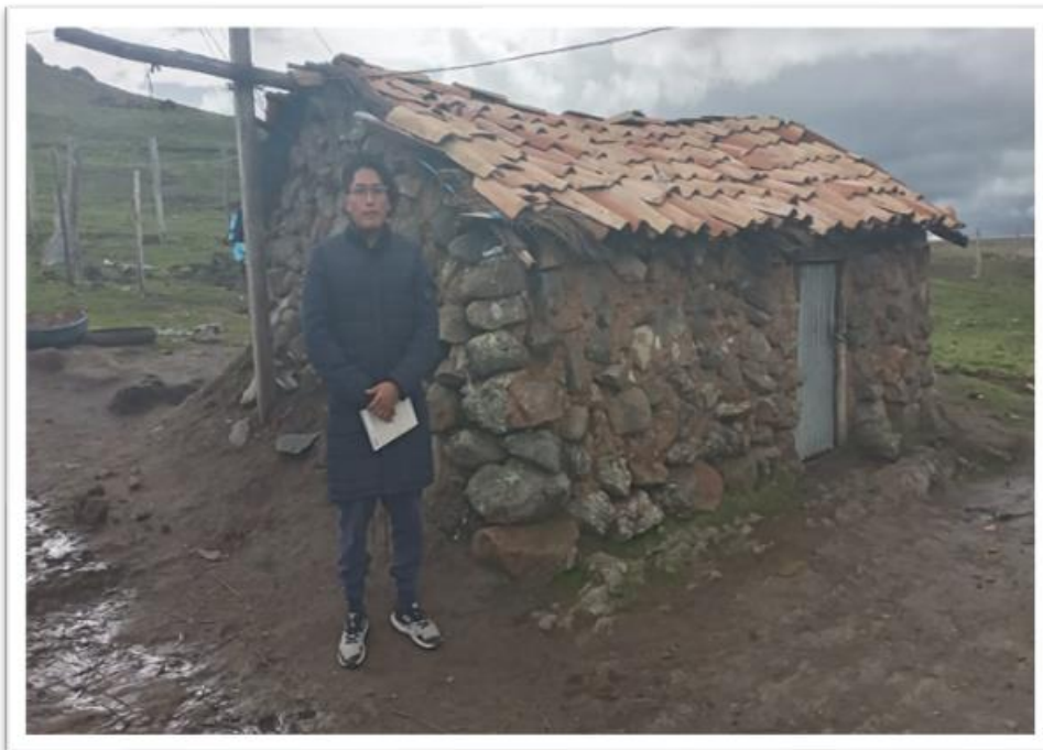
Imagen 23: vivienda sin la incorporación del poliestireno
