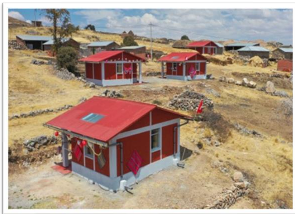
Imagen 2: conjunto de viviendas con incorporación del poliestireno Región Cuzco.
