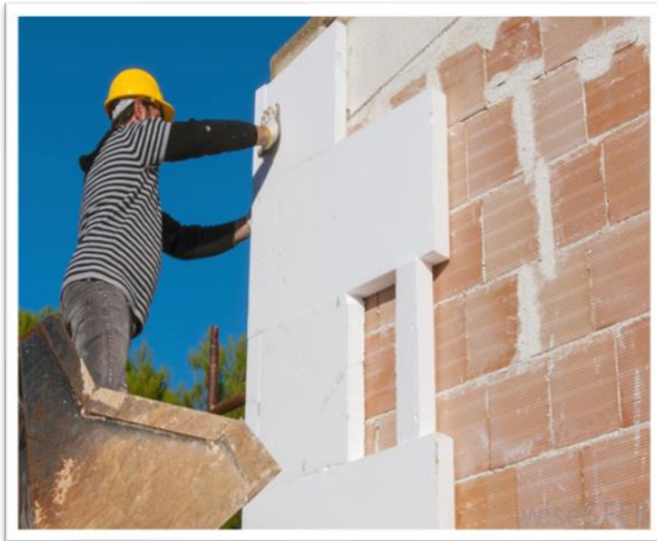
Imagen 7: el poliestireno es usado en aislamientos térmicos.
