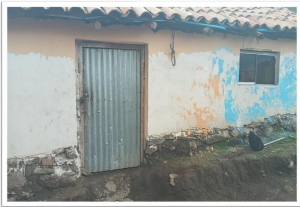
Imagen 22: vivienda sin la incorporación del poliestireno
