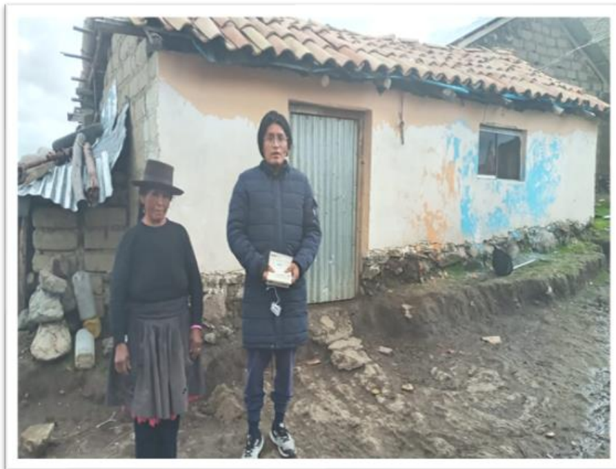
Imagen 21: vivienda sin la incorporación del poliestireno
