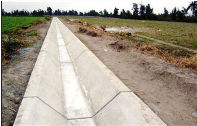
Figura 7. Canal revestido con concreto Fuente: (IngeCivil, 2016)
