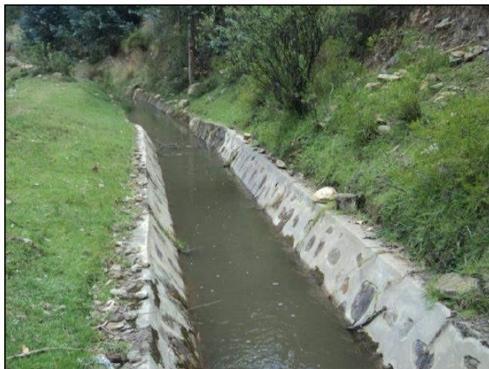
Figura 6. Canal revestido con mampostería
