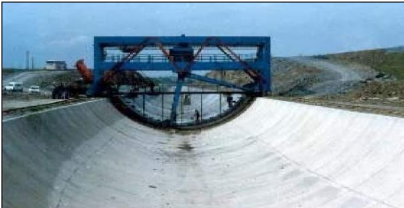
Figura 3. Canal de sección circular Fuente: (Abreu & Lara , 2015)
