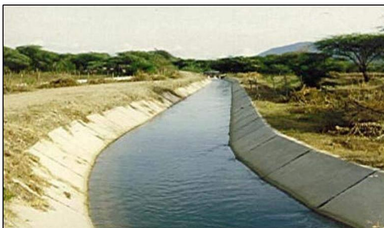
Figura 1. Canal de sección trapezoidal Fuente: (Abreu & Lara , 2015)
