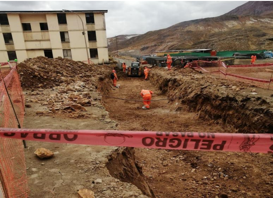
Trabajadores en obra
