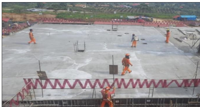
Figura 3.29 Curado de c° de losa maciza, bloque C nivel 2.
