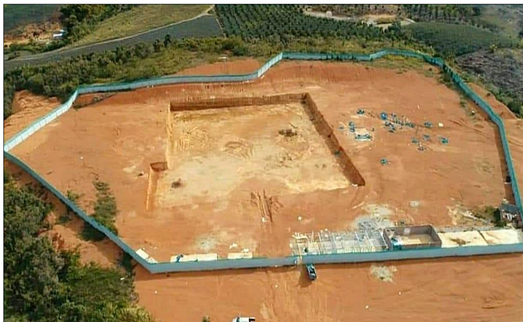
Figura 3.16 Obra Hospital de San Martín de Pangoa.
