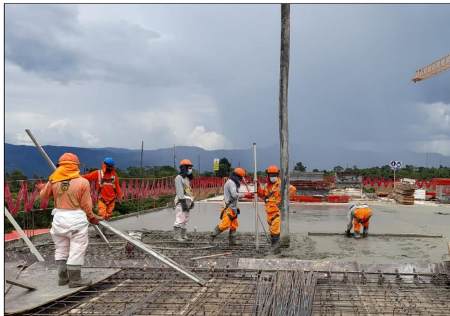
Figura 3.28 Vaciado de c° de losa maciza, Bloq C nivel 2.
