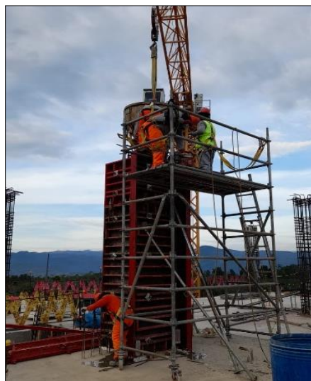
Figura 3.26 Vaciado de concreto, bloque B nivel 2.
