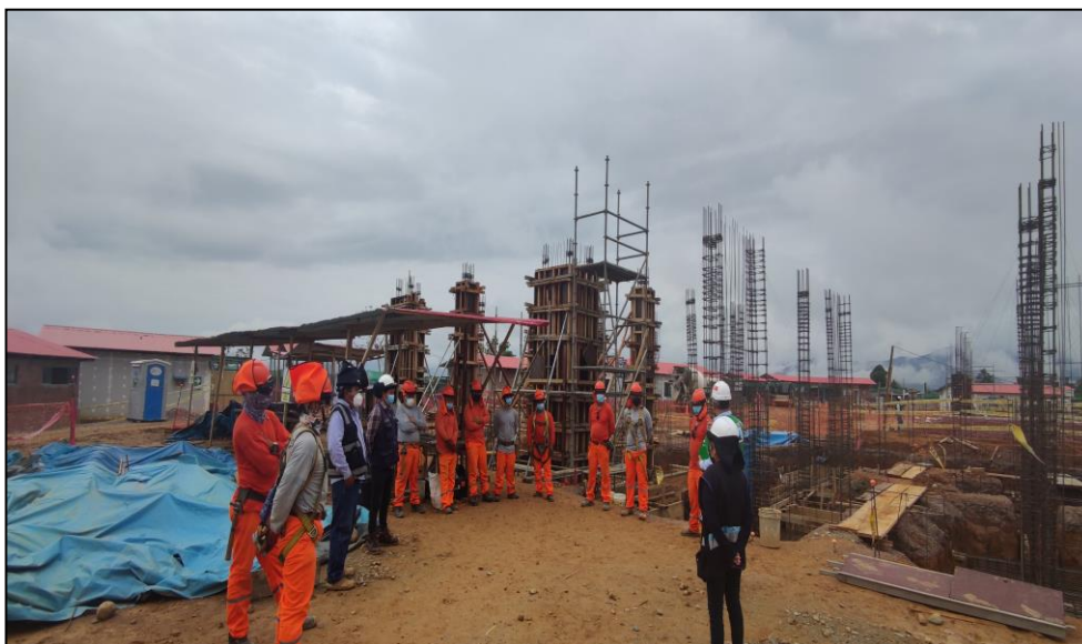
Figura 3.31 Capacitación de control de calidad en campo.
