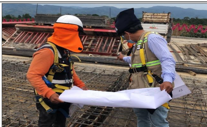
Figura 3.27 Losa maciza y vigas, bloque C nivel 2.
