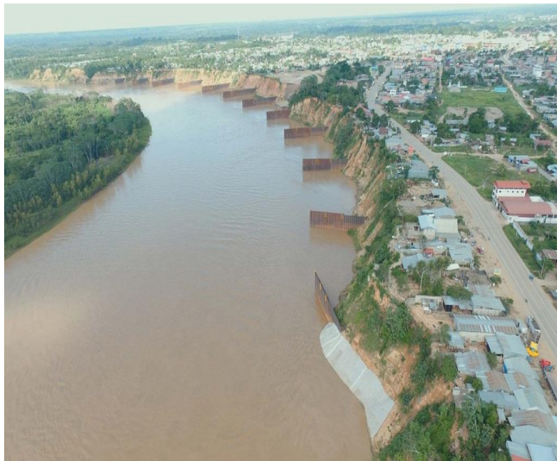
Figura 6: Defensa ribereña Tipo Espigones Fuente: Google
