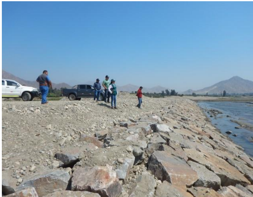
Figura 8: Defensa ribereña – Enrocado Fuente: Google
