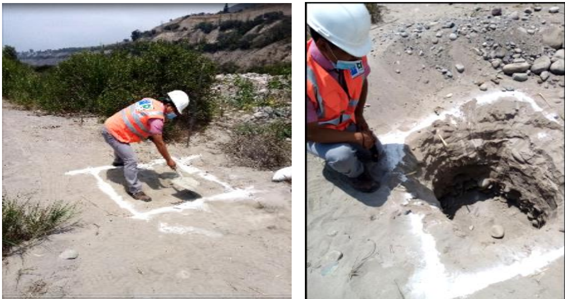
Figura 12: Inicio y Fin de la Calicata 1 Fuente: Propia
