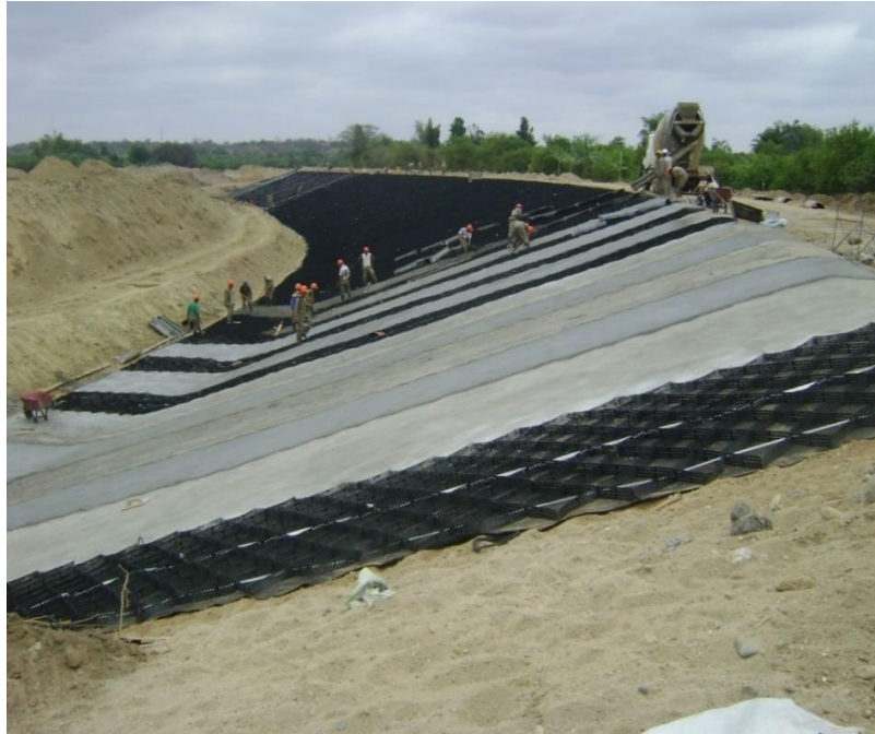
Figura 7: Defensa ribereña – Diques Fuente: Google
