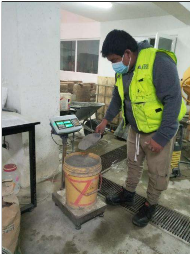
Fotografía 8. Pesado de cemento para elaboración del concreto.
