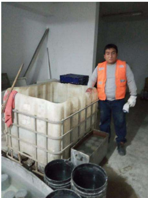
Fotografía 6. Curado de las muestras de concreto.
