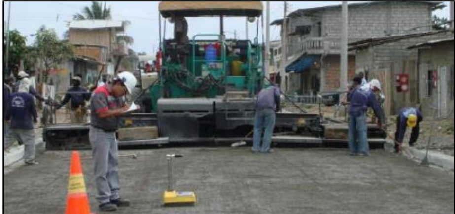
Figura 13. Esparcimiento del pavimento compactado. Fuente: Carrión y Masapanta (2018).
