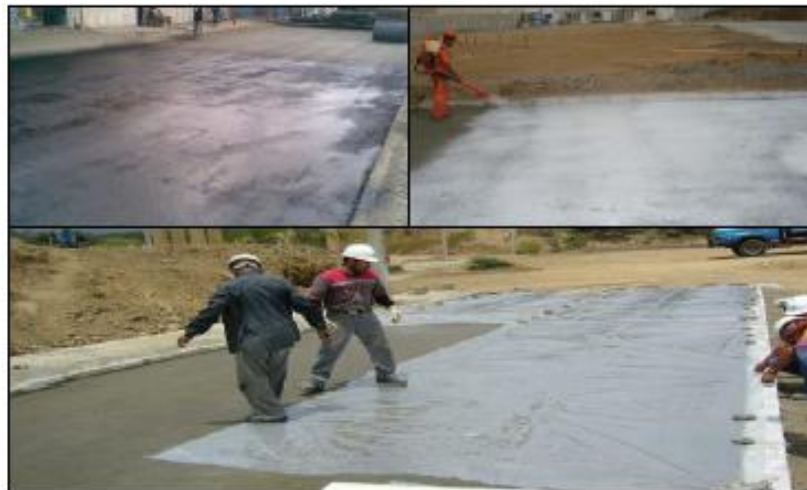
Figura 12. Emulsiones y curados para el concreto compactado con rodillo. Fuente: Carrión y Masapanta (2018).
