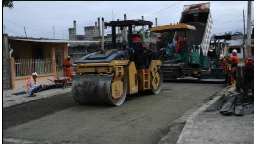
Figura 11. Compactación del concreto con rodillo vibratorio. Fuente: Carrión y Masapanta (2018).
