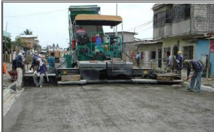
Figura 10. Tendido del concreto compactado mediante pavimentadora. Fuente: Carrión y Masapanta (2018).
