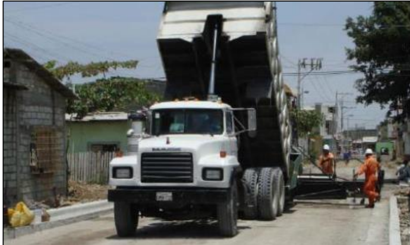
Figura 09. Colocación de CCR con camiones. Fuente: Carrión y Masapanta (2018).
