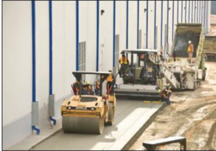
Figura 04. Concreto compactado con rodillo liso y pavimentadora. Fuente: Saldaña (2017).
