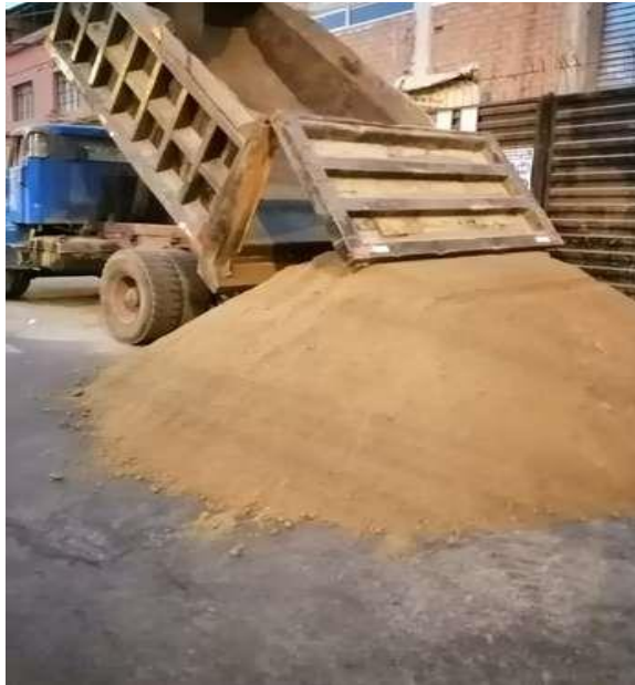
Figura 9. Entrega del material para la sub base del mejoramiento vial del Jr.Arica Fuente: Elaboración propia.
