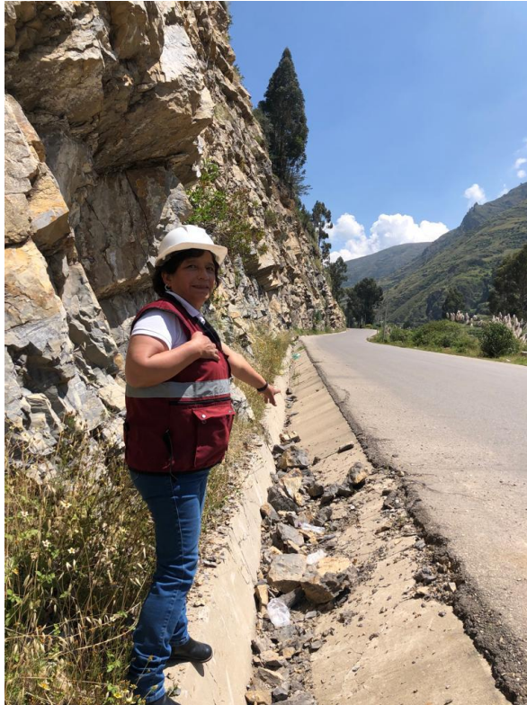
Figura 1 Desprendimiento de rocas en la vía Carretera Huancayo Cañete tramo Chupaca – Colpa paradero San Blas
