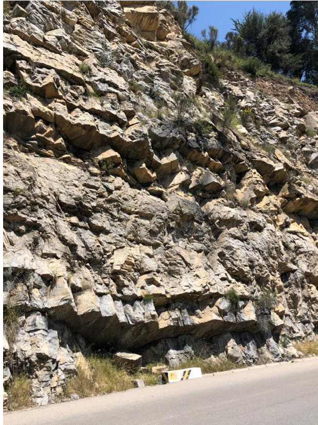
Figura 7 Se aprecia el paquete de calizas y en la parte superior la capa de suelos con la presencia de árboles como el eucalipto, quinual, entre otros.
