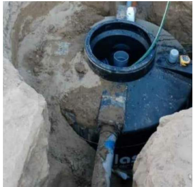
Compactación y llenado del biodigestor
