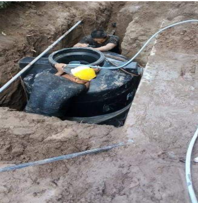
Instalación del biodigestor
