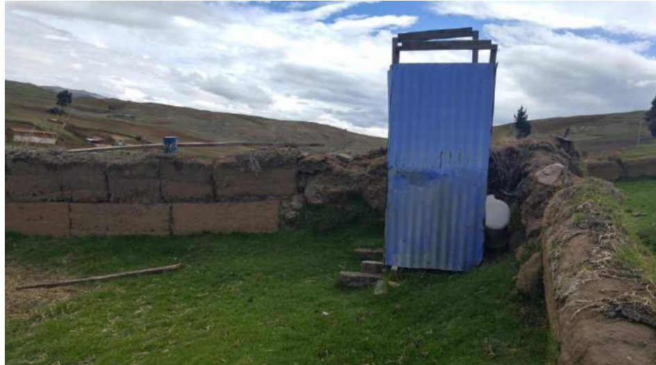
Figura 8 Letrina artesanal de calamina en estado deplorable e inadecuado Fuente: Elaboración propia.
