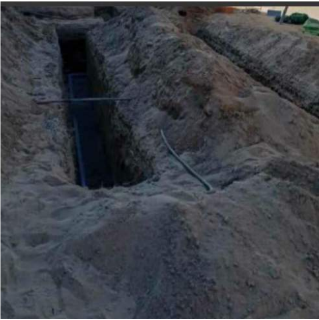
Excavación zanja de percolación
