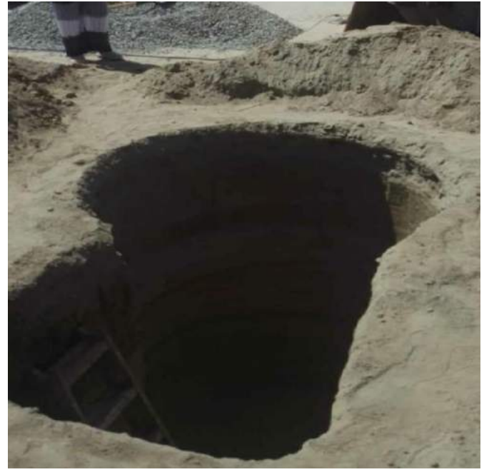
Inicio de la excavación para biodigestor
