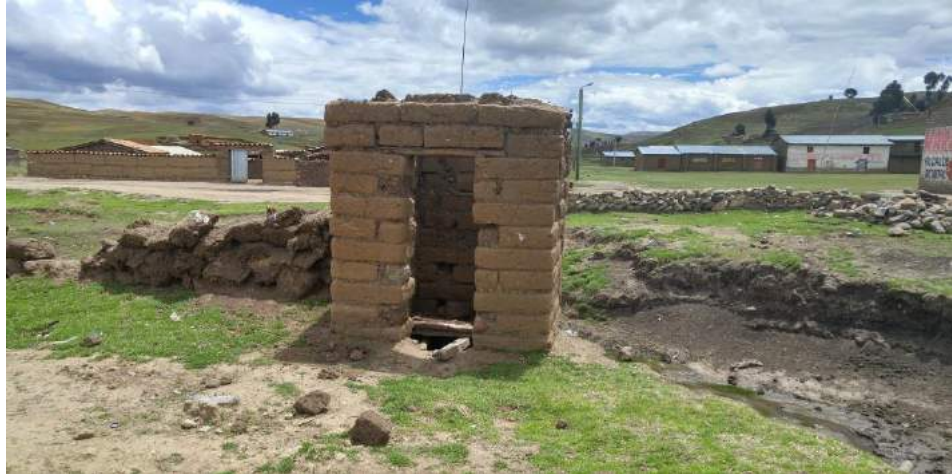
Figura 7 Letrina artesanal de adobe en estado deplorable e inadecuado Fuente: Elaboración propia.
