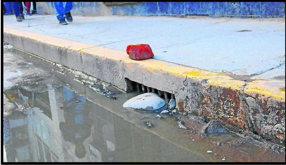
Fotografía 3. Evidencia donde colapso del sistema de alcantarilla
