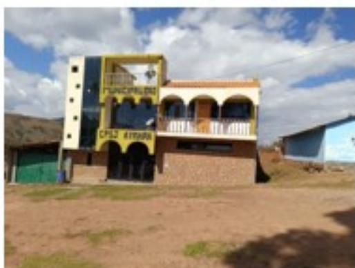
Imagen 21: Edificación comunal – Insostenible en todos los aspectos.
