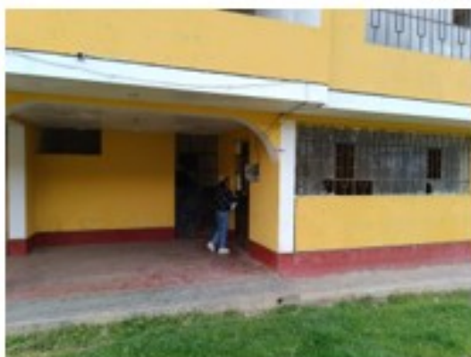
Imagen 23: Edificación comunal – Insostenible en todos los aspectos.
