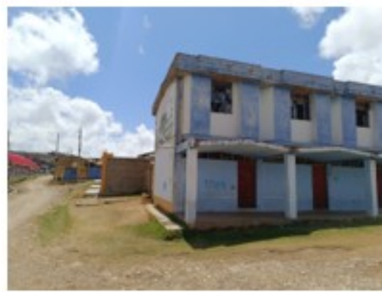
Imagen 16: Edificación comunal – Insostenible en todos los aspectos.
