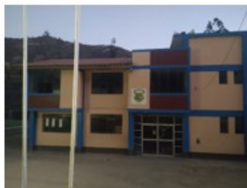
Imagen 22: Edificación comunal – Insostenible en todos los aspectos.
