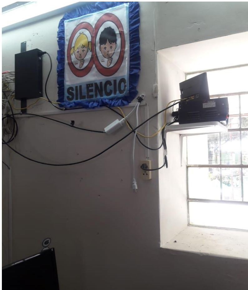
Ilustración 1: Posición del Access Point o Router de acceso a la red externa
