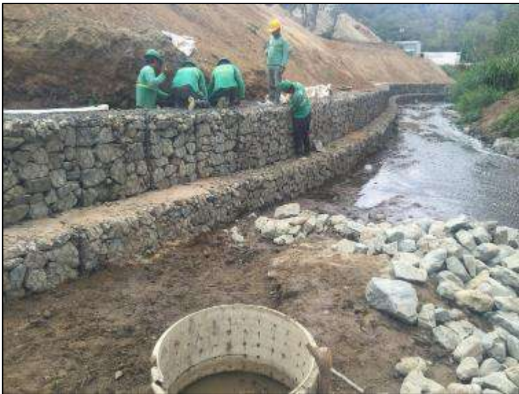
Figura 2. Construcción de gaviones Fuente: (GeoCon, 2023)
