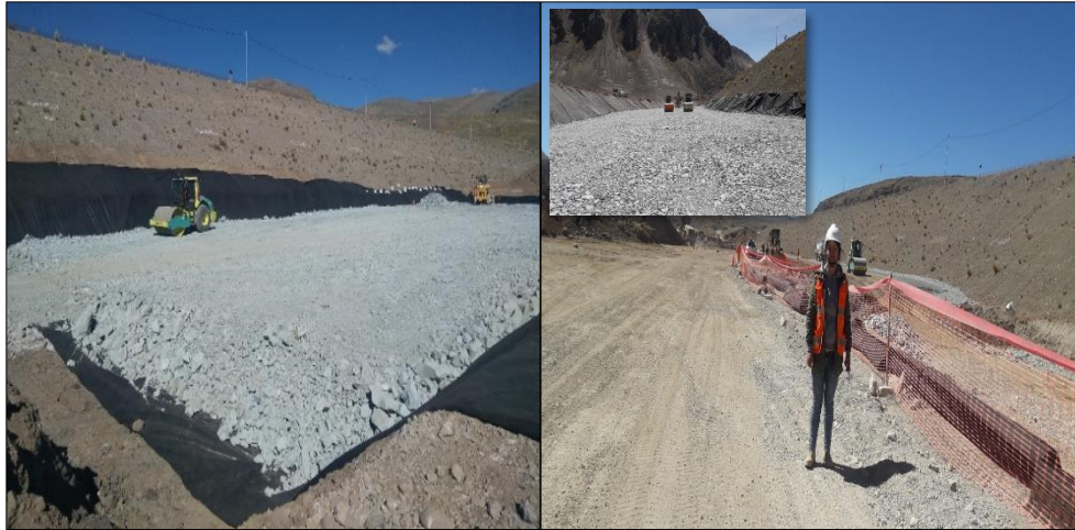
Figura 6: Compactación del material de mina con rodillo vibratorio de 20 tn.
