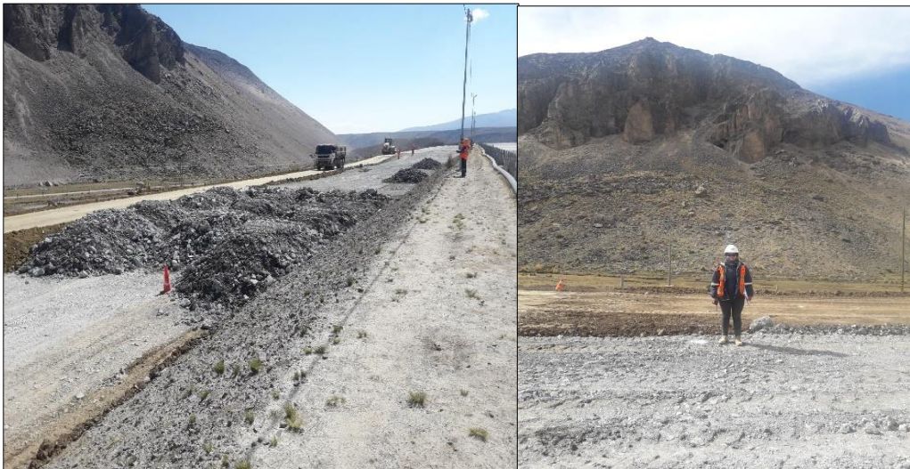
Figura 4: Material desmonte de mina sobre la plataforma del dique
