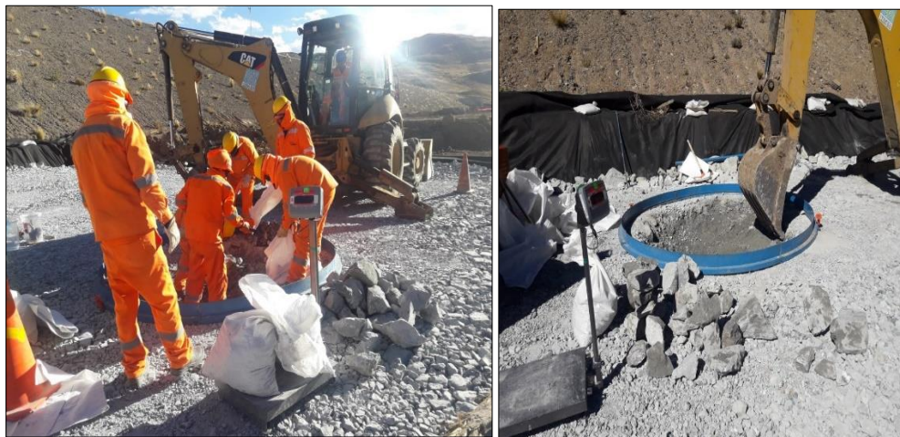
Figura 7: Excavación y extracción de material para ser pesado en kg.
