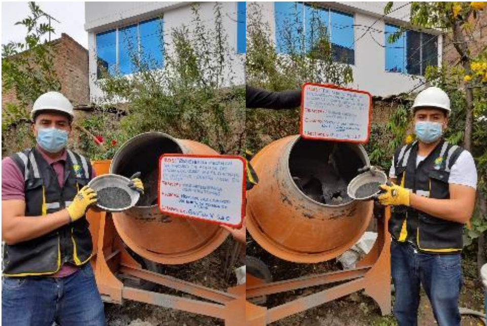
Fotografía 21. Mezclado del concreto con adición de escoria de cobre en 5 % y 10 %.
