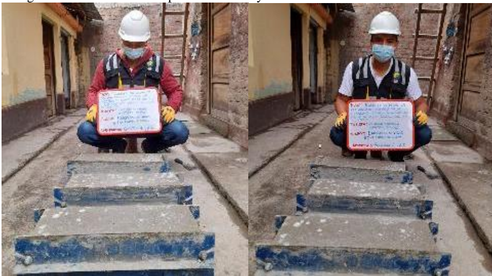
Fotografía 24. Elaboración de vigas al 10 % y 15 % de escoria de cobre.
