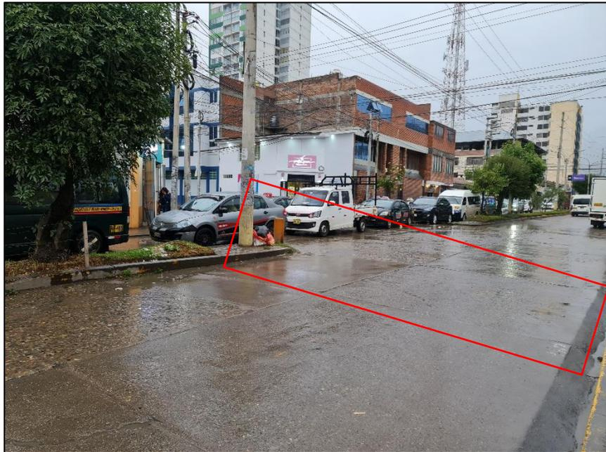
Figura 14: Señales horizontales Pr. Centenario inexistentes pavimento en mal estado.
