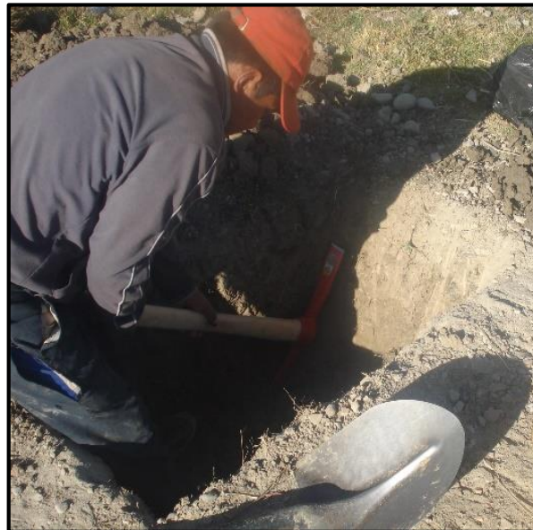
Figura 2. Excavación de la calicata
