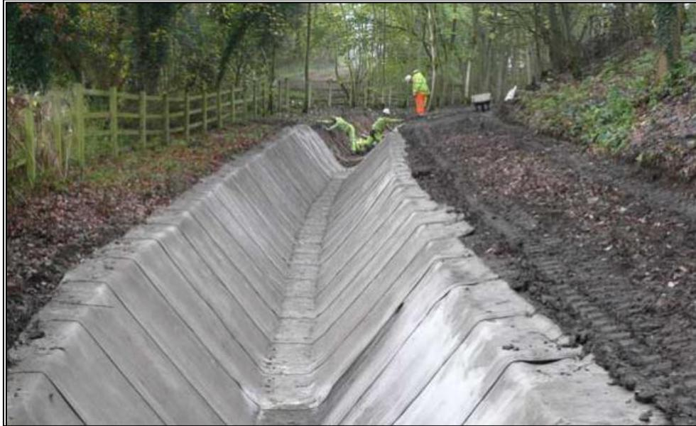
Figura 26: Sistema de canales prefabricados para el drenaje de desvío de un riachuelo.
