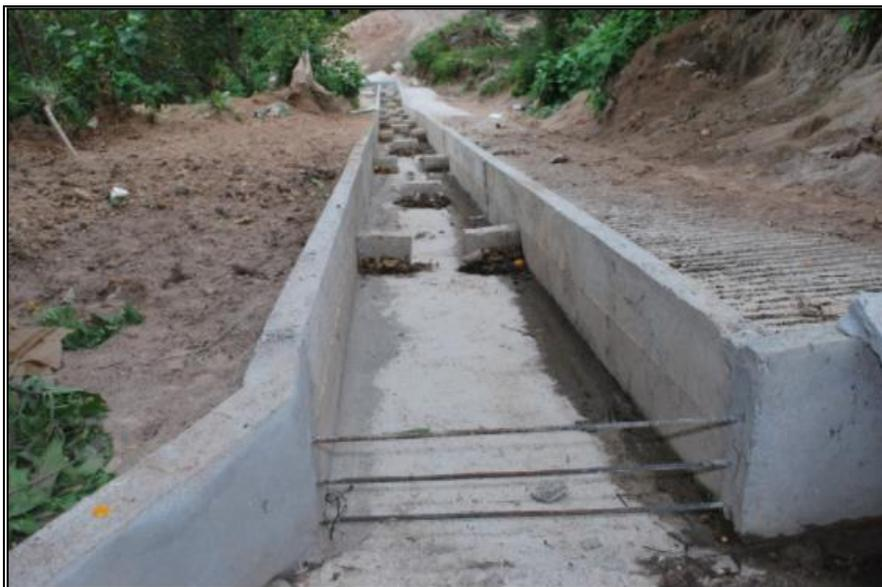
Figura 27: Sistema de canales con graderías para flujos con alta velocidad.
