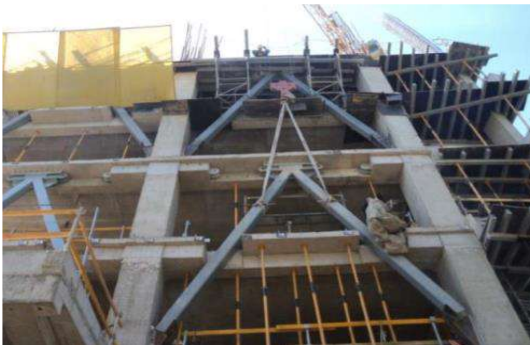
Figura 31: Disipador Viscoso uniendo más de dos entrepisos.
