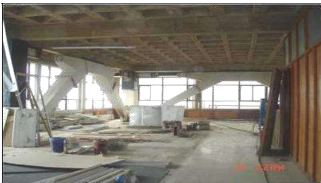
Figura 20: Amortiguador de fluido viscoso Aeropuerto Jorge Chávez Fuente: GCAQ-Ingenieros Civiles
