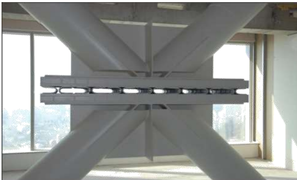
Figura 8: Disipador friccional (Tipo Pall)
