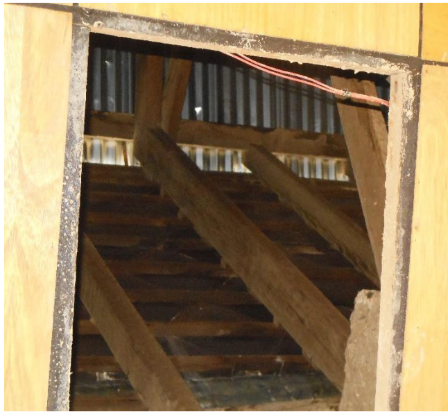
Figura 4.40. Vista del techo.
