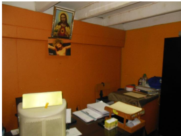
Figura 4.9. Vista de la humedad que se presenta en las vigas de madera.
