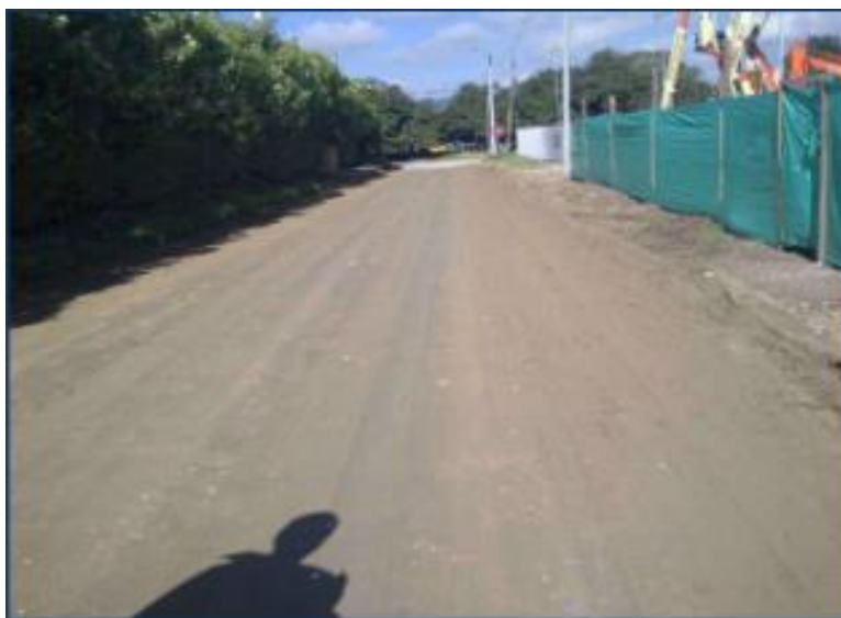
Imagen 05: Estabilización calles del municipio de Chia
