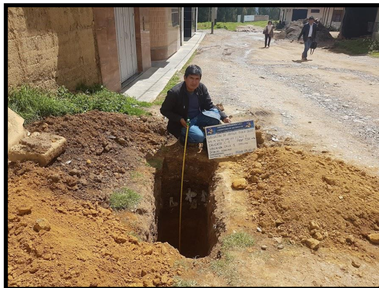
Imagen 22: Vista de la calicata C-2
