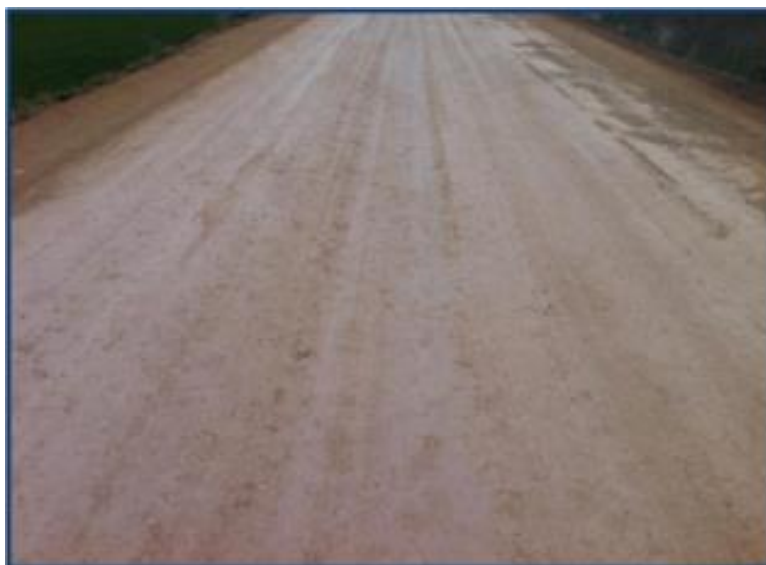
Imagen 04: Estabilización de accesos a finca privada
