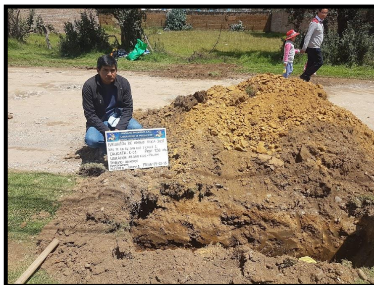
Imagen 21: Vista de la calicata C-1
