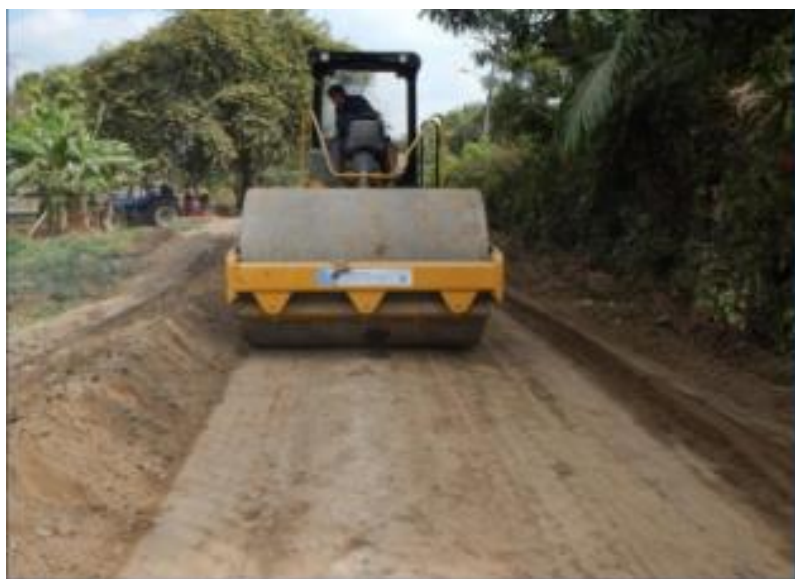
Imagen 10: Estabilización camino en Yaguachi
