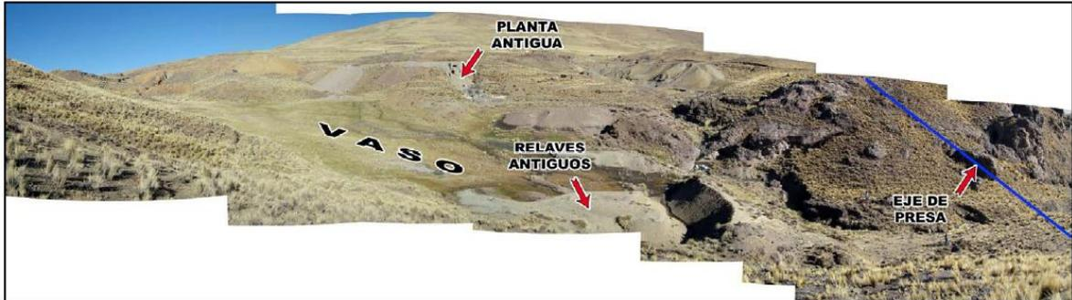
Figura N°1 Vista mostrando el sector del eje de presa y vaso del depósito. El eje de presa interesará rocas volcánicas del Grupo Tacaza (T – ta) cubiertos parcialmente por depósitos morrénicos (Q – mo).
