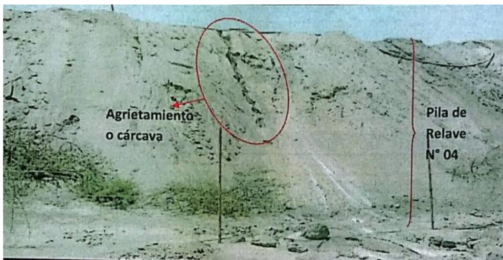
*Figura 7 Se puede observar muestra de cárcavas en el talud de la presa de relaves.
