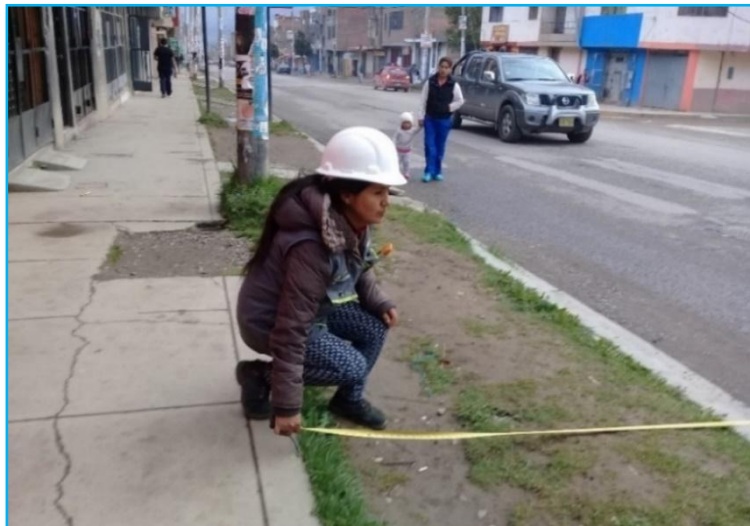
Figura 12 Inspección del tramo en estudio
