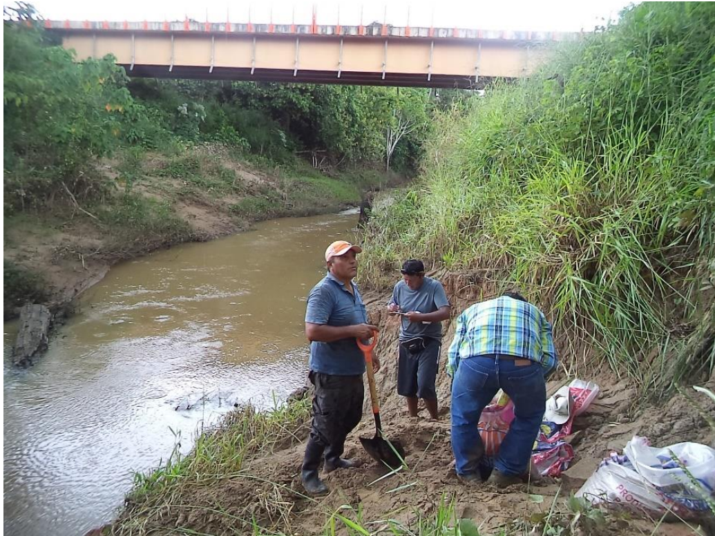
Figura 34:Extracción de la arena del rio Noaya en sacos de 50 kg. Fuente Propia.
