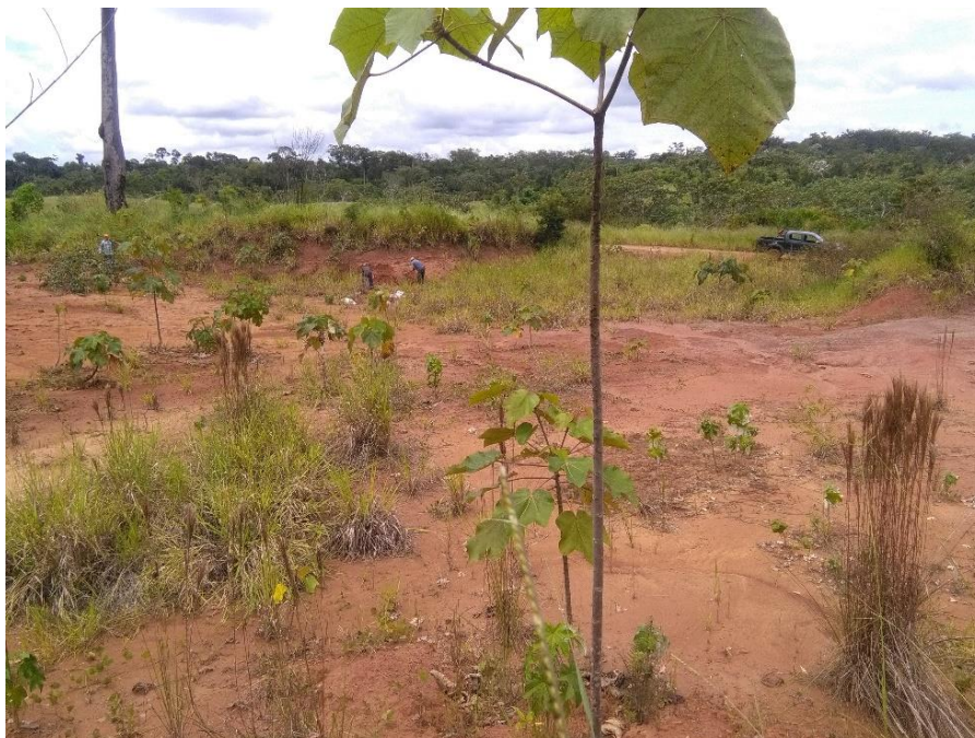
Figura 28: Vista panorámica de la Cantera Tropezón y crecimiento rápido de la vegetación km 10+680. Fuente: Propia.
