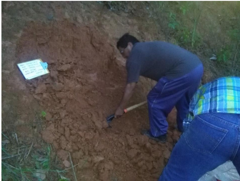
Figura 20: Extracción del material de la cantera de la carretera vecinal la Joya – Infierno Kilómetro 15+800. Fuente: Propia.
