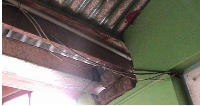
Figura 4.8 Cableado horizontal instalado por el techo
