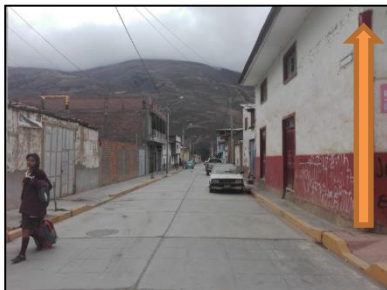
VIVIENDA DE 2 NIVELES
