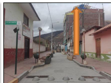
VIVIENDA DE 3 NIVELES
