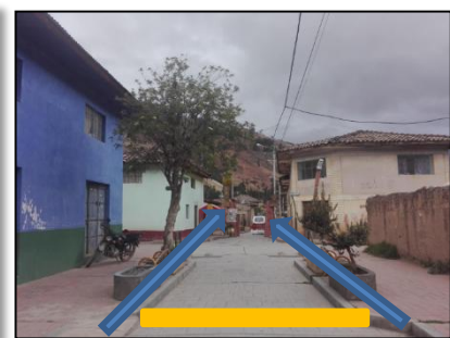
CIRCULACION CON UN CONFORT INADECUADO
