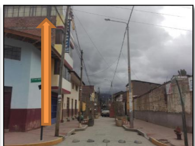
VIVIENDA DE 3 NIVELES
