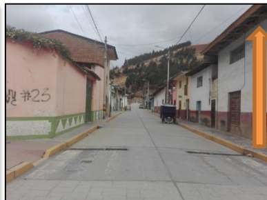
VIVIENDA DE 2 NIVELES
