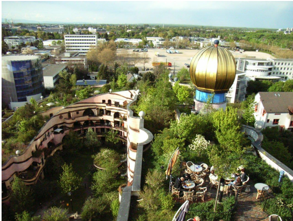
FIGURA Nº 19: Edificio Waldspirale, Alemania, cubierta intensiva.
