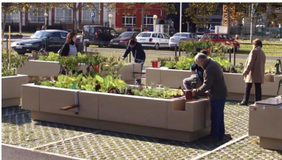
FIGURA Nº 10: Pavimento permeable, Barcelona.
