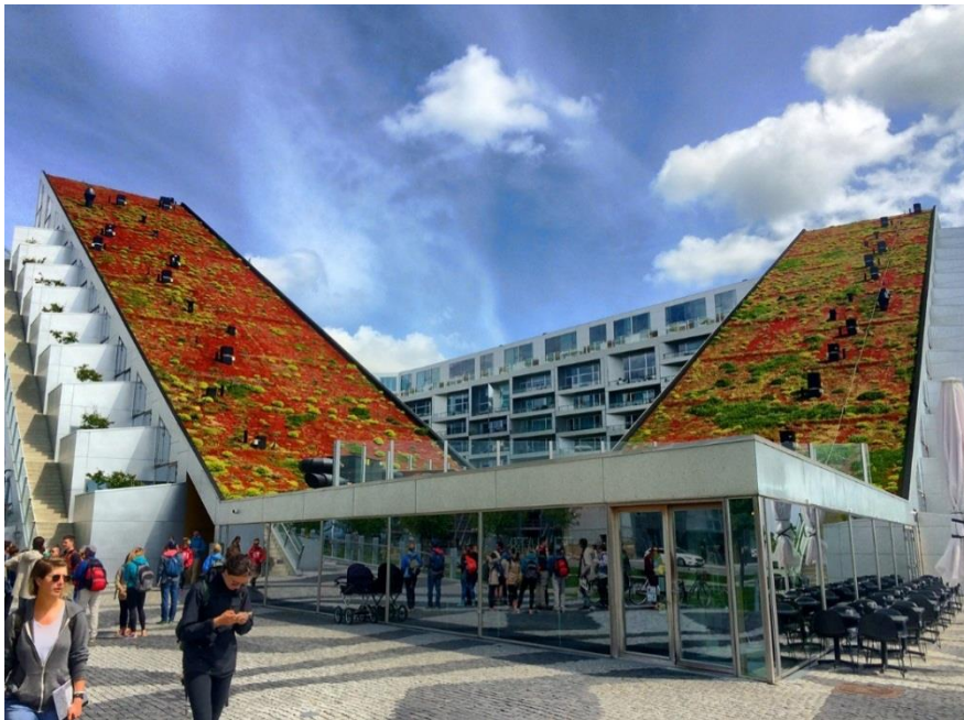
FIGURA N° 18: Edificio 8 house Copenhagen, cubierta extensiva.
