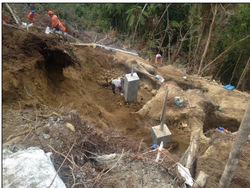
Figura 8: Construcción de cimientos en torres de Alta tensión
