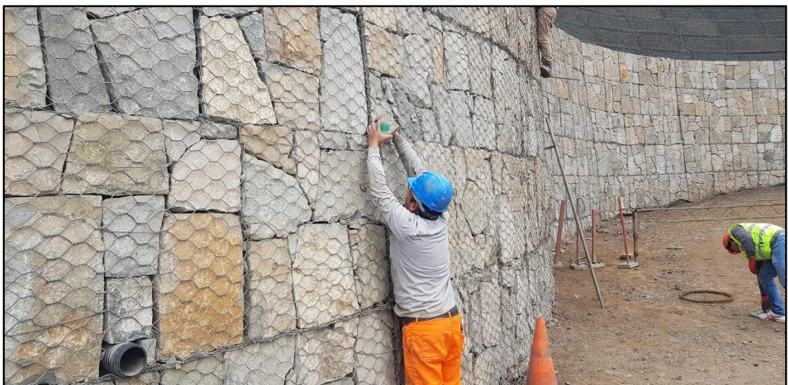
Figura 19. Instalación de placas de control topográfico.
