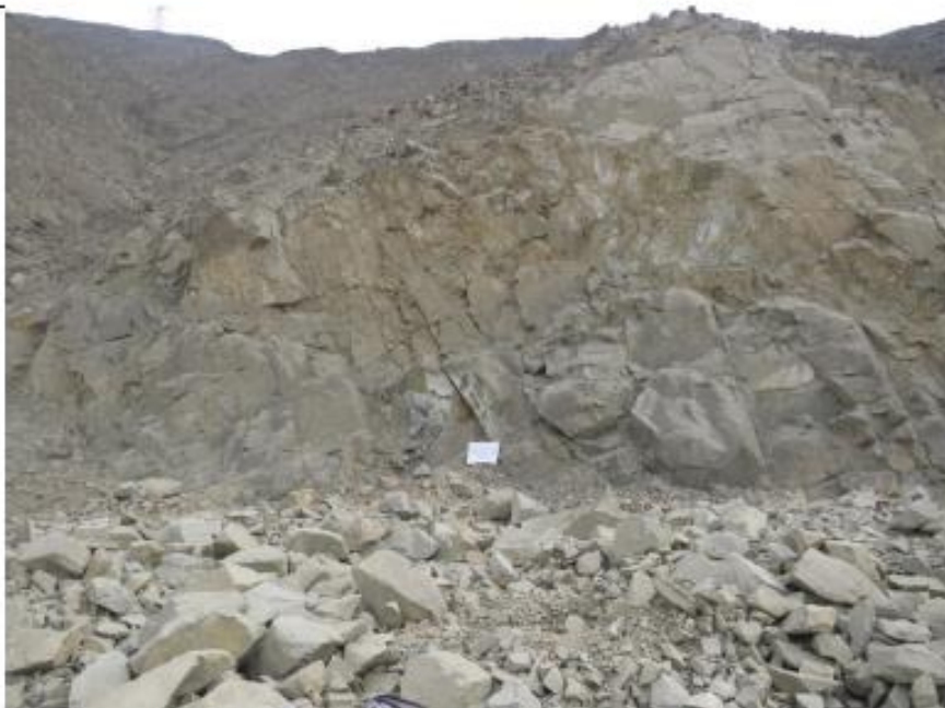
Fotografía N°6: Estación geomecánica EG-03.
