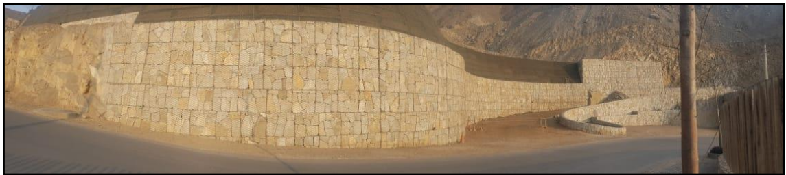
Figura 18. Área de estudio e instalación de placas de control topográfico.
