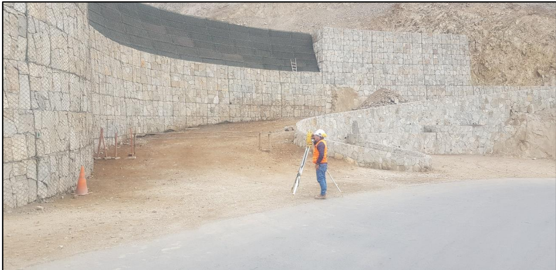
Figura 22. Lectura de los puntos de control topográfico.
