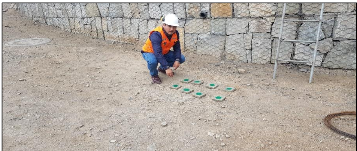
Figura 17. Suministro de las placas de control topográfico.
