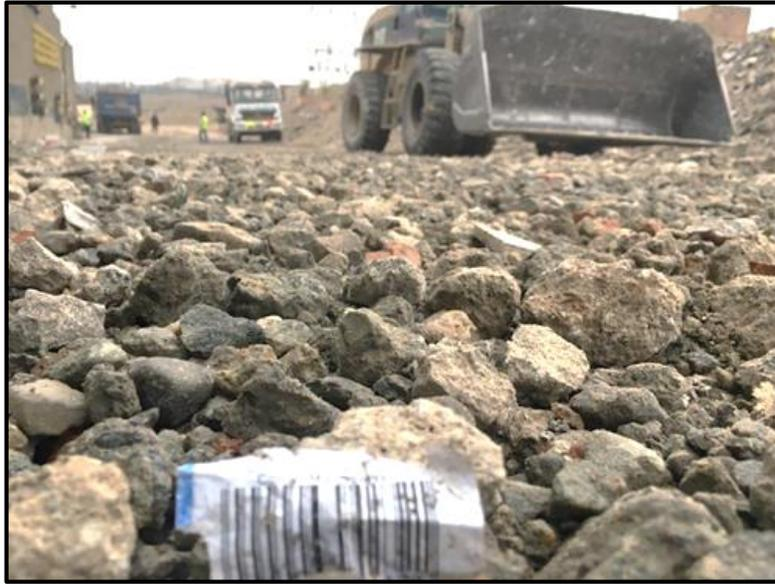
Figura 6: El concreto o escombros de construcción para triturar
