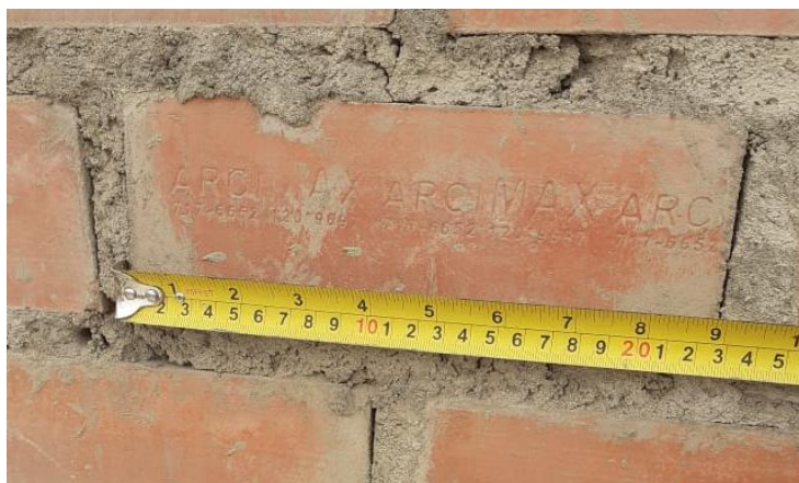
Fotografía 5. Medida de altura del ladrillo 9 cm
