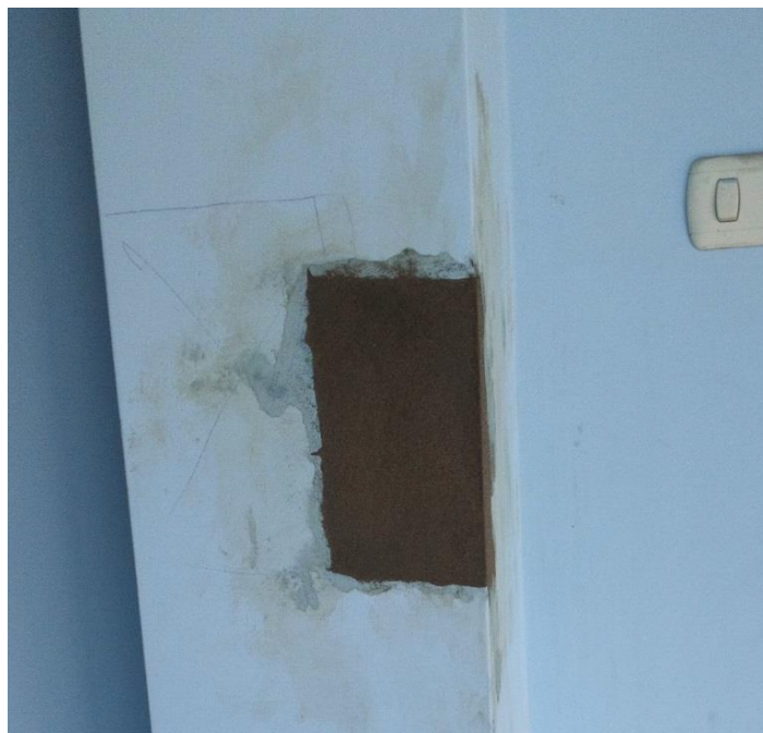
Fotografía 12. Resane de las muestras de ensayos.
