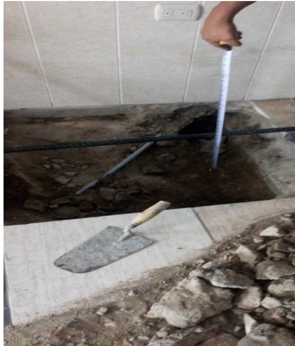
Fotografía 23. Midiendo la altura del sobre cimentación
