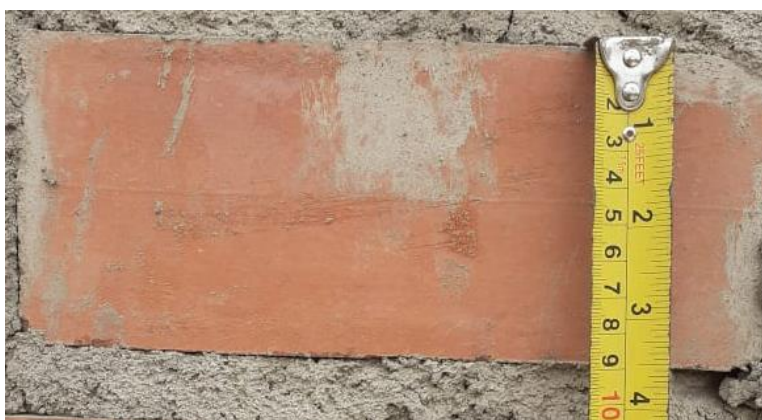
Fotografía 5. Medida de altura del ladrillo 9 cm
