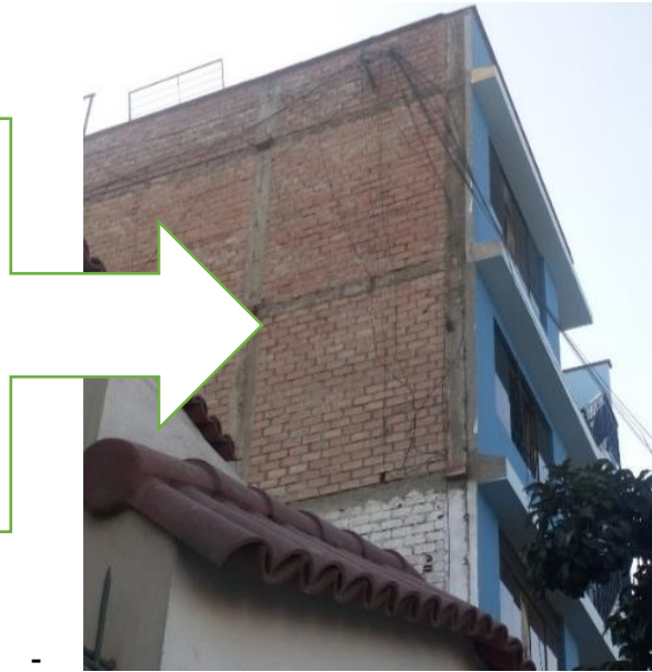
Fotografía 2. Medida de la columna de confinamiento.
