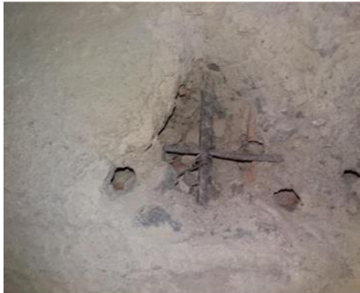
Fotografía 16. Auscultación acero de refuerzo en viguetas
