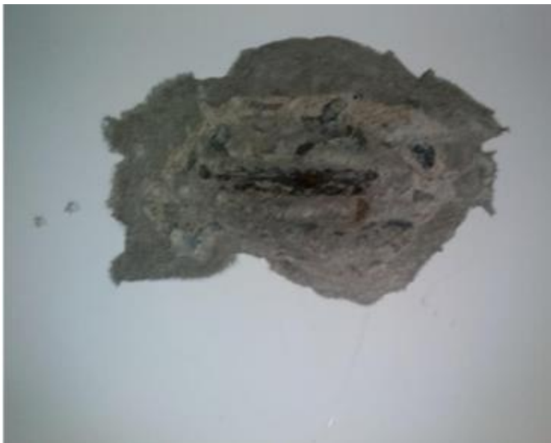
Fotografía 15. Auscultación de viga
