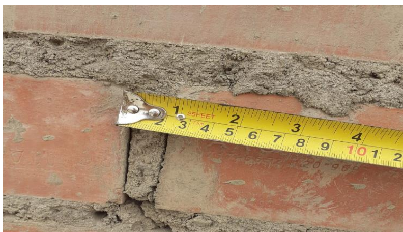
Fotografía 8. Ancho de mortero vertical 2.2 cm
