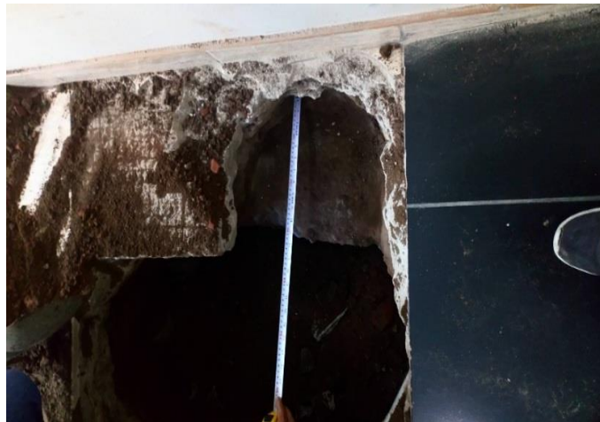
Fotografía 22. Midiendo el ancho de la cimentación
