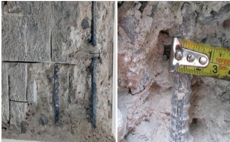
Fotografía 14. Acero vertical 1/2" y estribo de 6mm en Columnas
