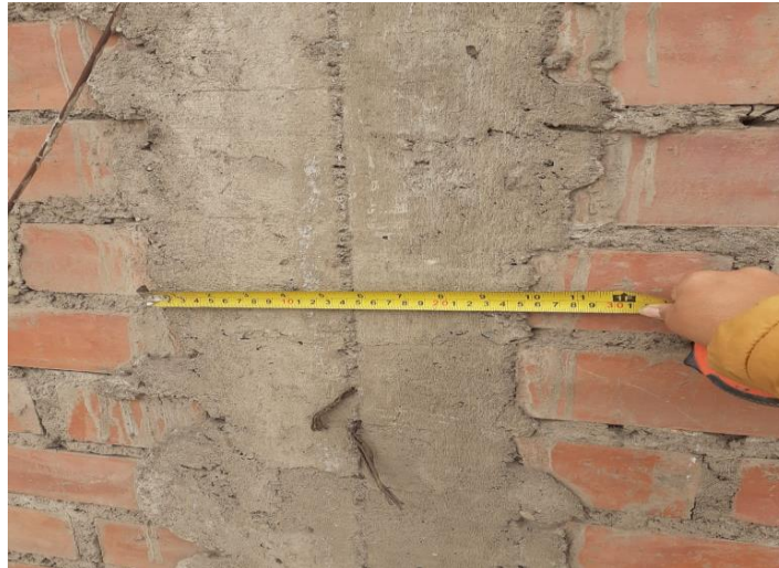
Fotografía 2. Medida de la columna de confinamiento.
