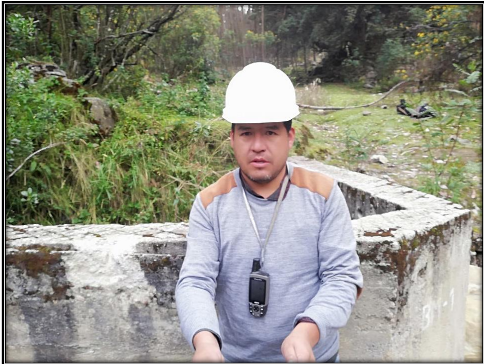
Fotografía 04: Toma de agua Putacca Arriba.
