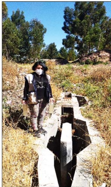
FOTO 04: Toma de muestra del afluente de la planta de tratamiento existente.
