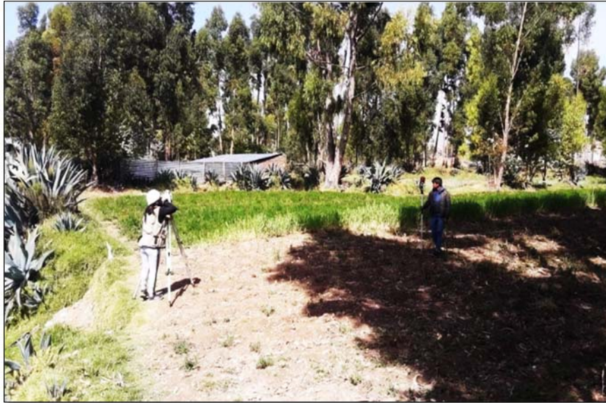
FOTO 03: Levantamiento topográfico (toma de puntos) del área donde se proyectará la nueva planta de tratamiento de aguas residuales.
