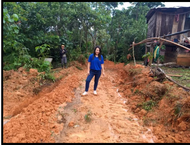
Imagen 3: Lugar donde pasará la línea de conducción.
