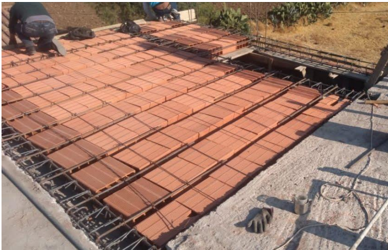
Collage de fotos N° 05: Encofrado de losa aligerada.
