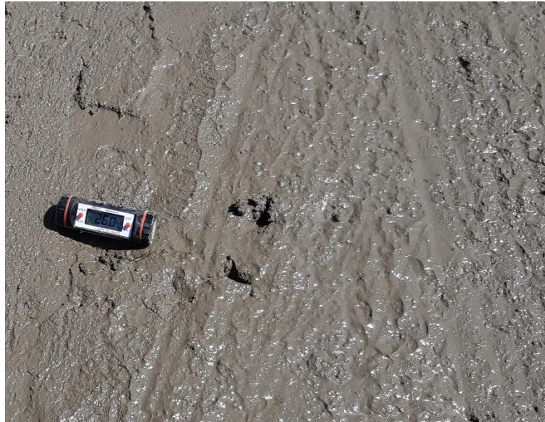
Figura N° 31: Registro de la temperatura del concreto.
