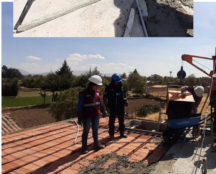
Collage de fotos N° 06: Vaciado de concreto en losa aligerada.
