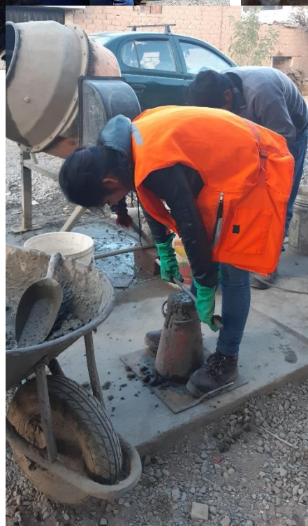
Collage de fotos N° 07: Ensayo de asentamiento del concreto (slump).
