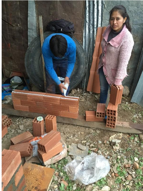
Fotografía 8. Elaboración de murete de ladrillo pandereta con junta de masa polimérica.
