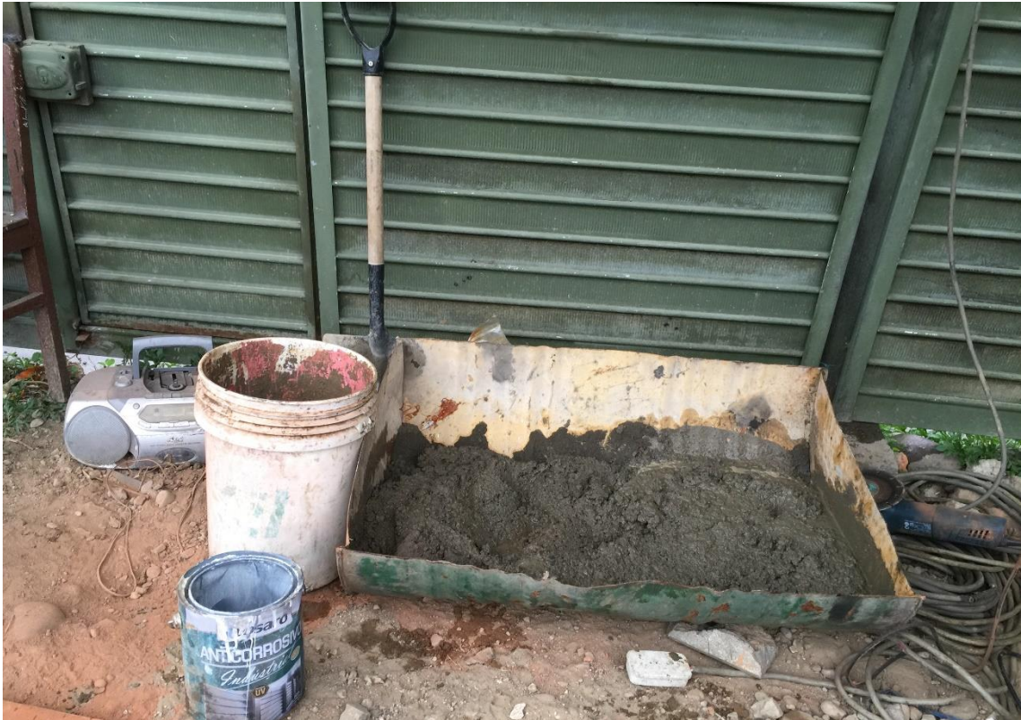
Fotografía 1. Vista de mortero para la utilización en pilas y muretes.
