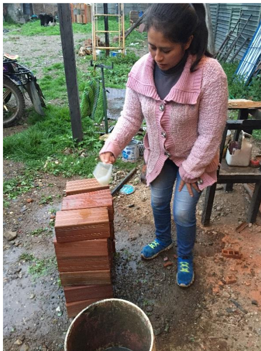
Fotografía 2. Proceso de humedecimiento de unidades de albañilería.
