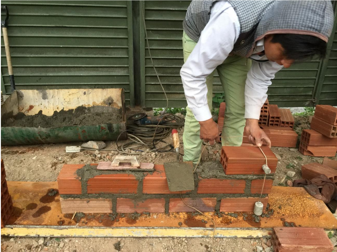
Fotografía 4. Elaboración de murete de ladrillo pandereta con junta de mortero tradicional (cemento, agregado y agua).
