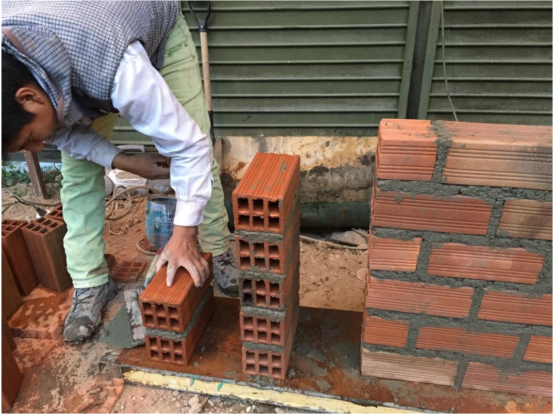
Fotografía 3. Elaboración de las pilas de ladrillo pandereta con mortero tradicional (cemento, agregado y agua).
