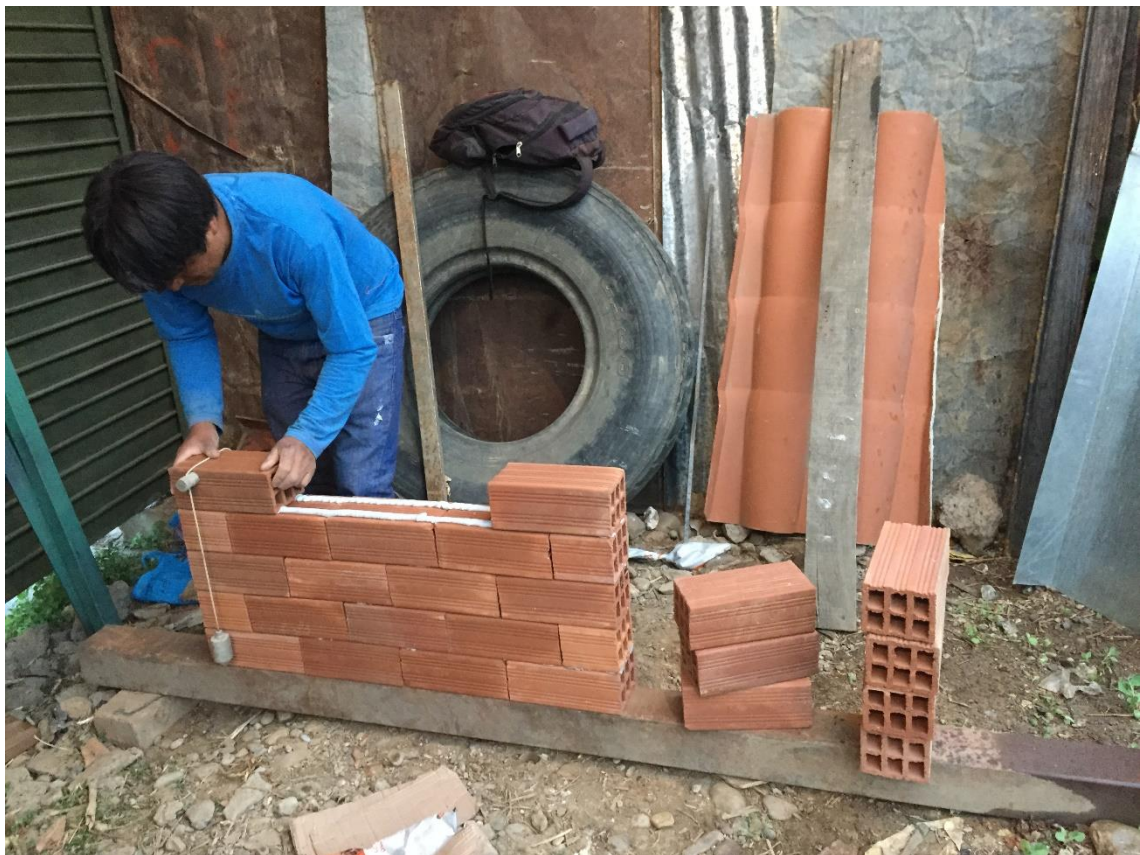
Fotografía 9. Nivelación de murete de ladrillo pandereta con junta de masa polimérica.
