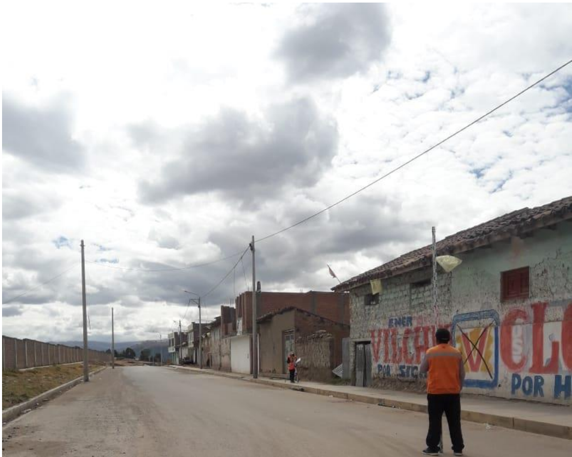
IMAGEN 5: LA IMAGEN MUESTRA LA LECTURA DE LOS PUNTOS MARCADOS, PARA OBTENER EL PERFIL LONGITUDINAL EN EL JR. BALCONCILLO.
