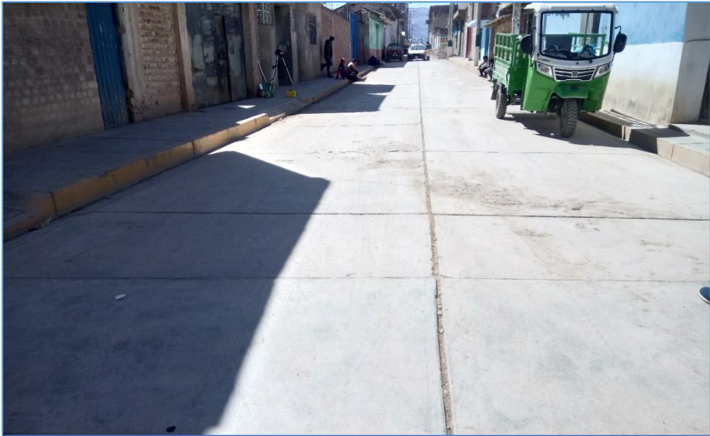
IMAGEN 1: LA IMAGEN MUESTRA AL JR. ESPERANZA, EN LA CUAL SE IDENTIFICA PRIMERO LA HUELLA DE LOS CARROS EN EL PAVIMENTO, PARA DESPUES PROCEDER CON EL MARCADO.
