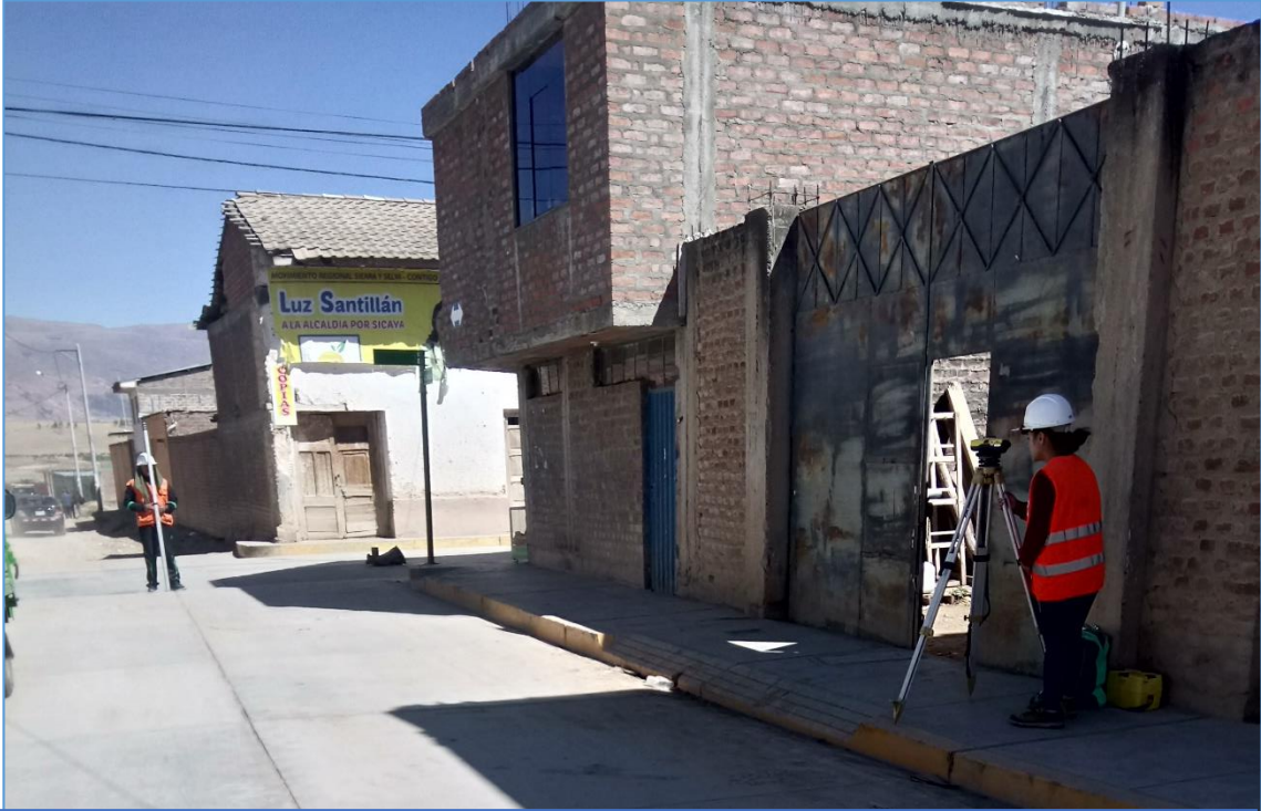
IMAGEN 3: LA IMAGEN MUESTRA LA LECTURA DE LOS PUNTOS MARCADOS, PARA OBTENER EL PERFIL LONGITUDINAL.
