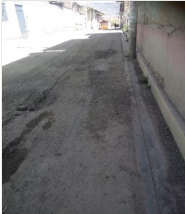
Figura 2: Vía con pavimentación flexible.
