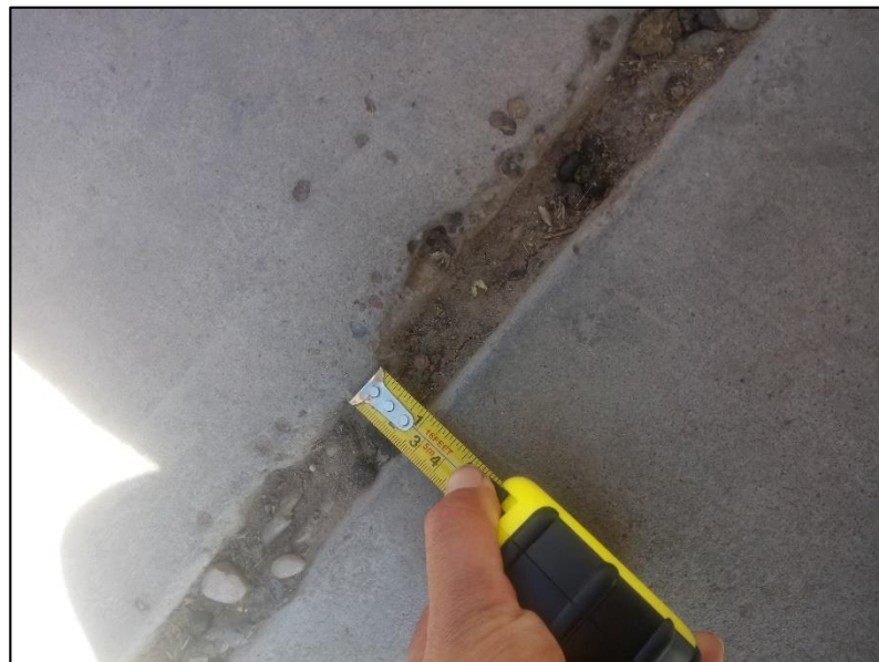
Figura 23: Longitud de junta del Jr. Buena Muerte (pavimento rígido)
