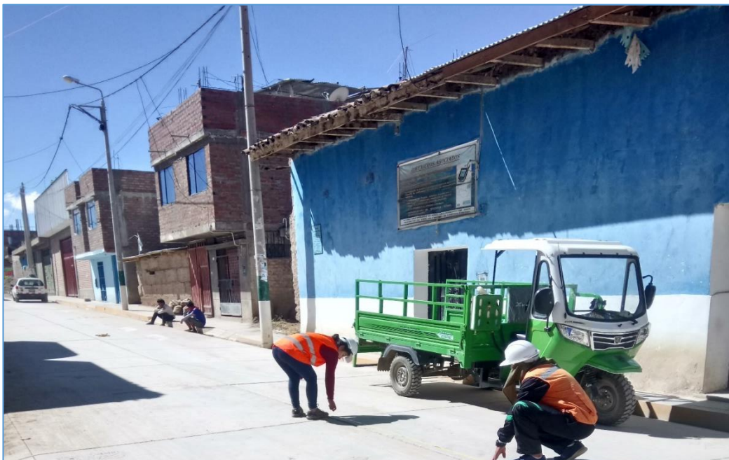
IMAGEN 2: EN LA IMAGEN SE OBSERVA EL MARCADO DE LA HUELLA DEL CARRO A CADA 25cm.
