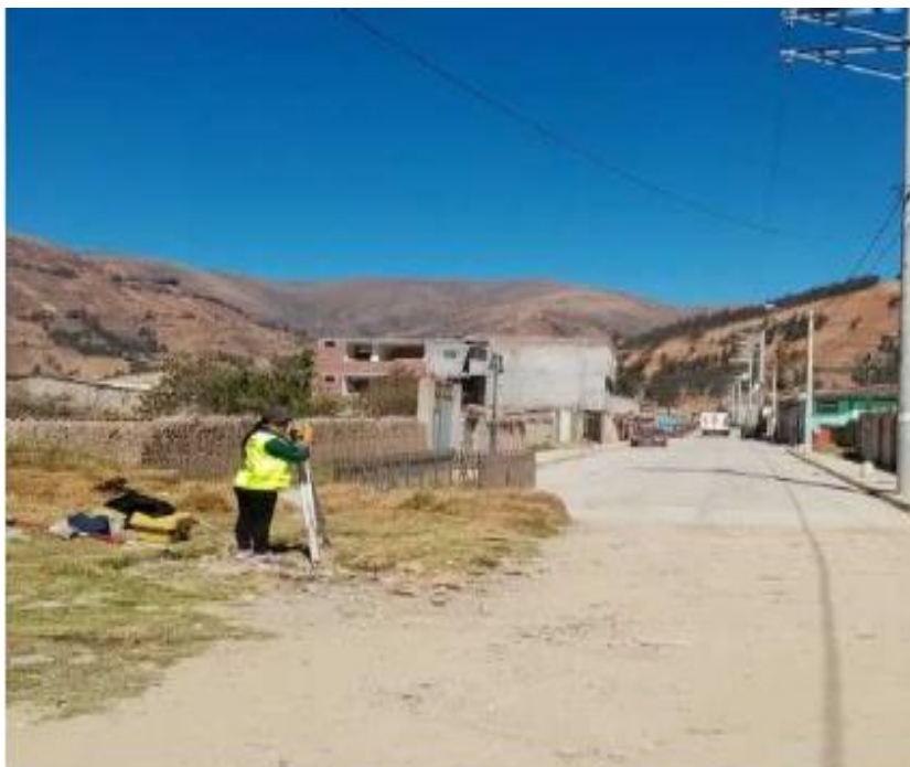
Fotografía 4. Levantamiento topográfico realizado para la propuesta del sistema de drenaje pluvial.
