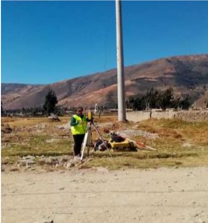
Fotografía 3. Muestra del levantamiento topográfico realizado con los equipos necesarios para la investigación.
