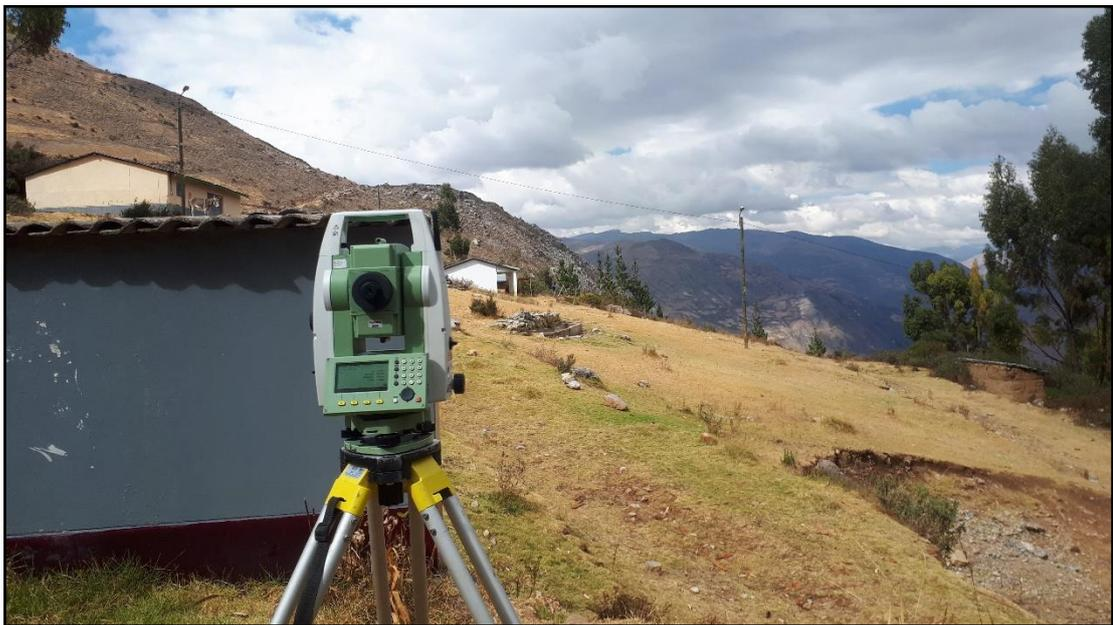
Fotografía N° 14: Poligonal cerrada del Atahualpa con estación total.
