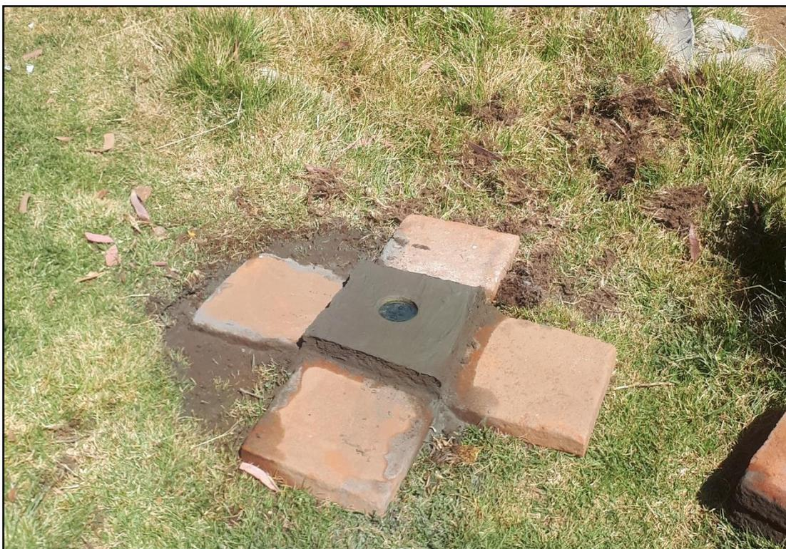
Fotografía N° 07: Monumentación de dados de concreto con placa para BM.
